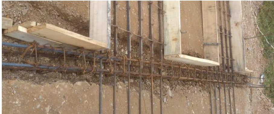
Ilustración 14 viga riostra
