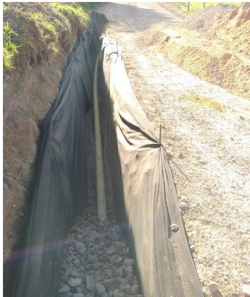
Ilustración 42 tubería filtrante
