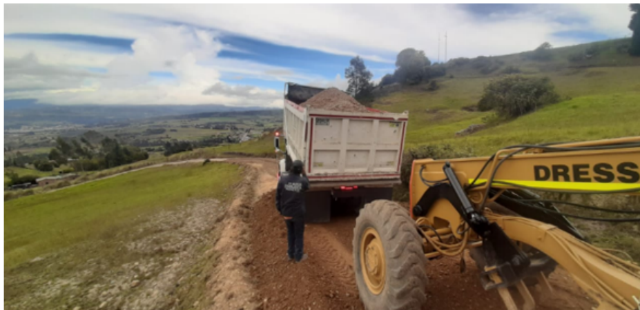
Ilustración 7 material de subbase
