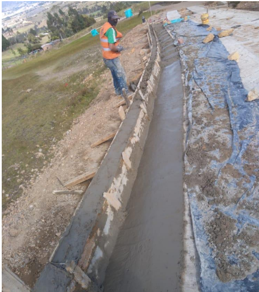
Ilustración 25 cuneta berma
