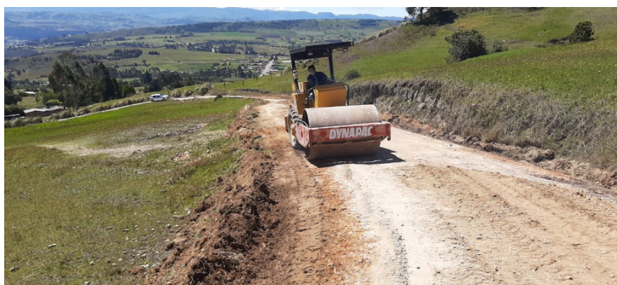
Ilustración 6 compactación de la banca existente
