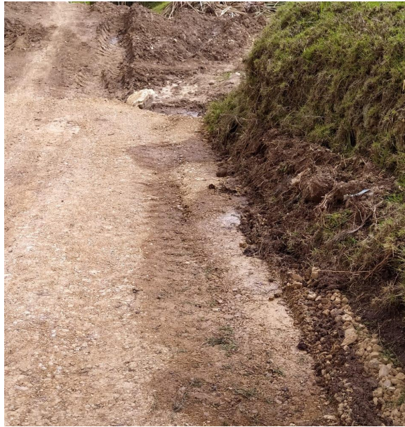
Ilustración 38 suelo inestable
