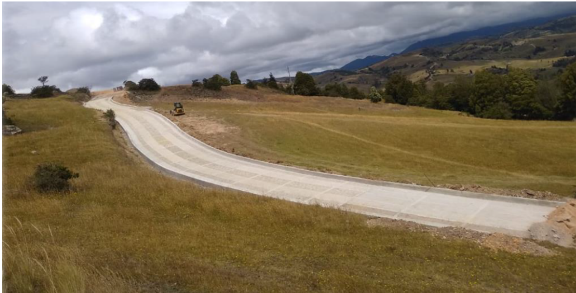
Ilustración 33 culminación de obra
