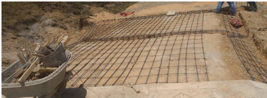
Ilustración 31 placa de transición
