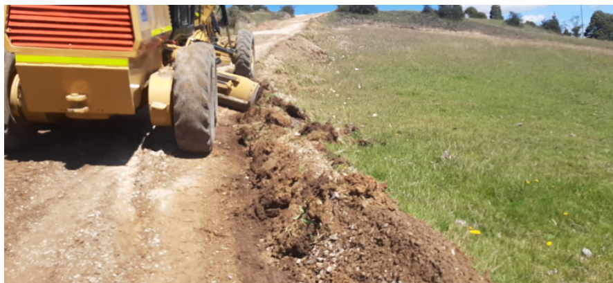
Ilustración 5 Perfilado
