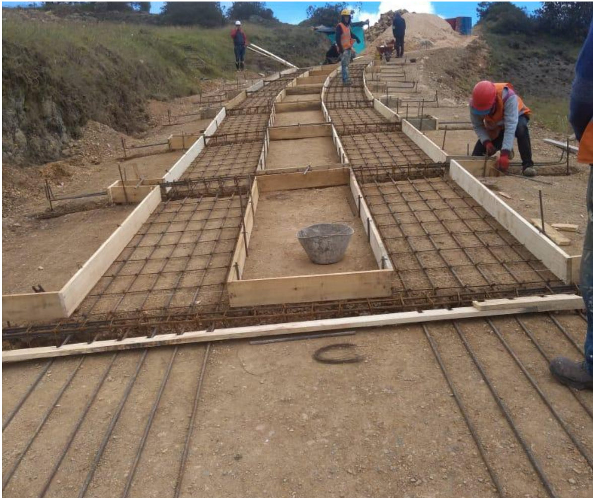
Ilustración 16 amarres de acero y encofrado
