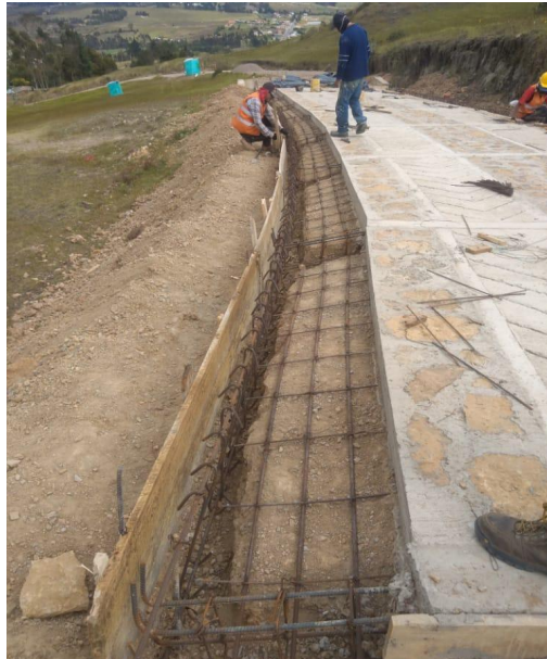
Ilustración 24 acero de refuerzo cuenta-berma
