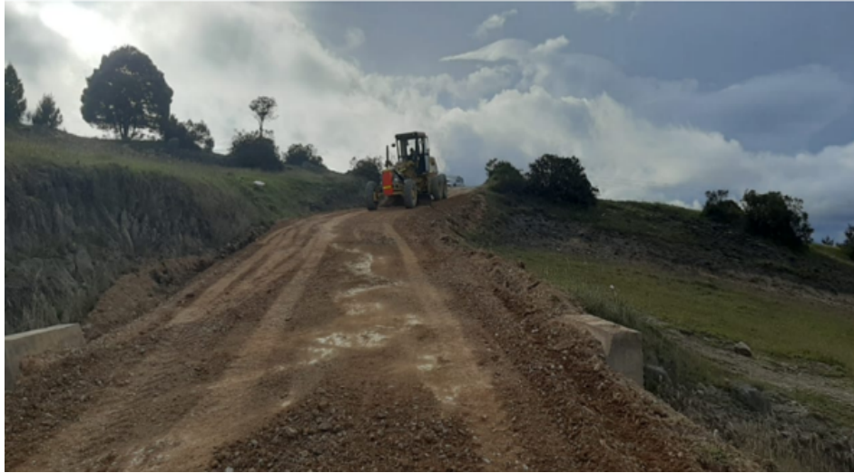
Ilustración 8 subbase
