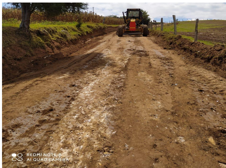
Ilustración 36 perfilado y compactación
