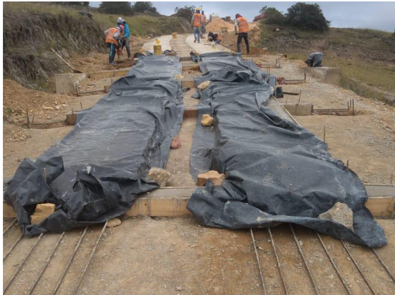
Ilustración 20 placa huella
