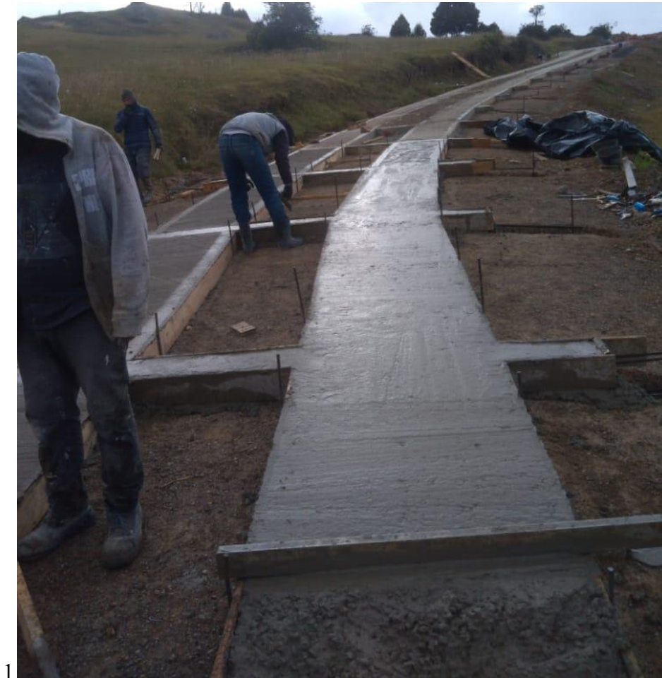
Ilustración 27 placa huella
