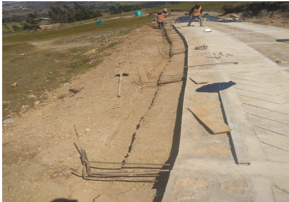
Ilustración 21 construcción placa huella y piedra pegada
