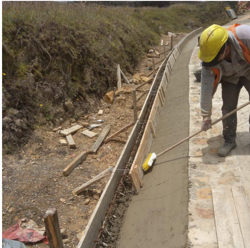
Ilustración 29 fundida cuneta-berma bordillo
