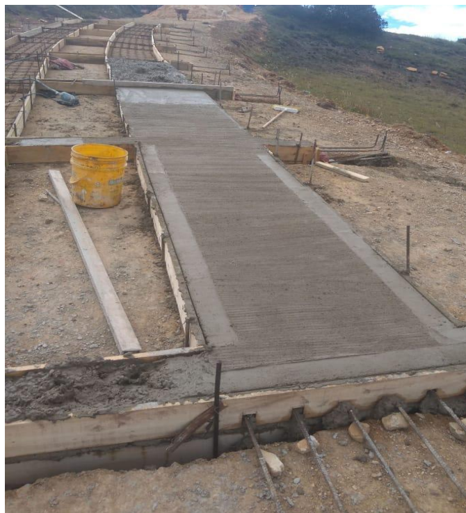
Ilustración 17 placa huella
