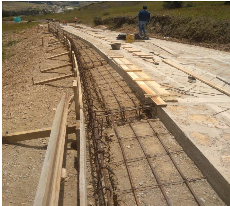
Ilustración 28 cuneta- berma costado derecho
