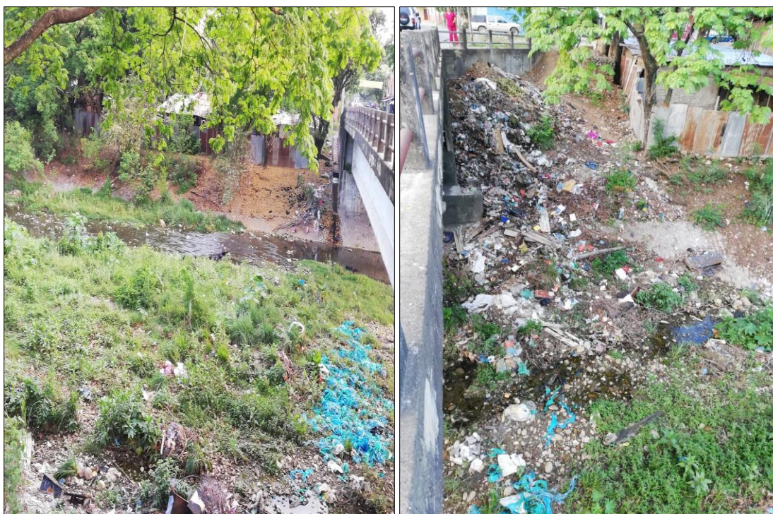
Figura 14. Contaminación por generación de residuos, parte baja del río del Oro.
