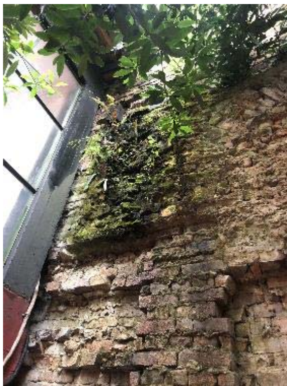
Imagen 3 Fotografía muro occidental zona escalera desde predio vecino. Fuente propia
