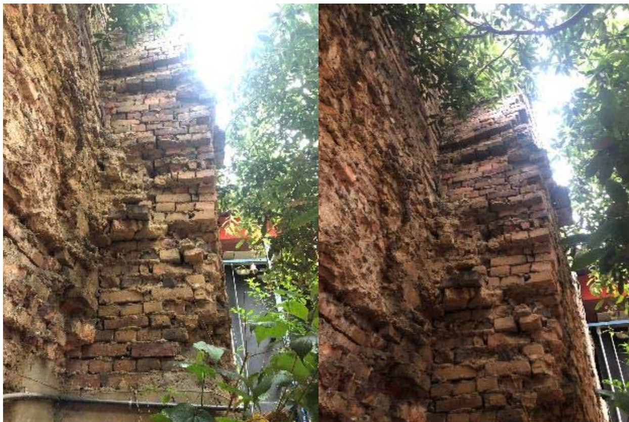
Imagen 14 Parte occidental del muro.
