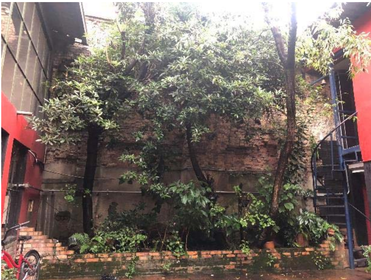
Imagen 9 Dimensión del muro occidental.
