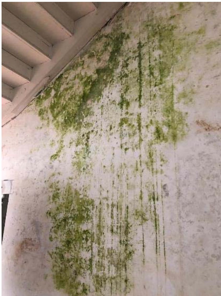
Imagen 5 Muro interno, costado occidental bajo escalera. Fuente propia.
