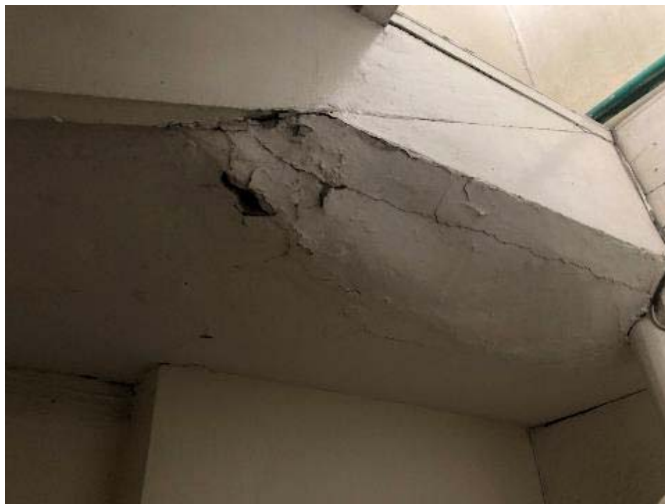
Imagen 23 Cielo raso, segundo piso. Fuente propia.
