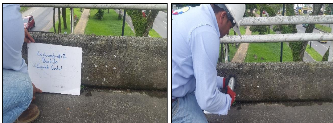
Figura 17. Ensayo de esclerometría en muro del tablero Fuente: Los autores.
