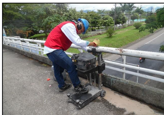
Figura 9. Proceso de extracción de núcleos en el tablero Fuente: Los autores.
