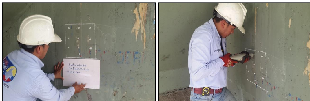
Figura 14. Ensayo de esclerometría en muros de escalera Fuente: Los autores.
