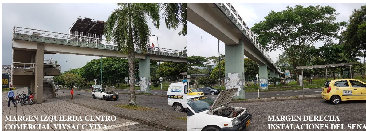
Figura 2. En el costado izquierdo se muestra el acceso al puente sector Centro Comercial Viva y al lado derecho se muestra el acceso por el SENA.
