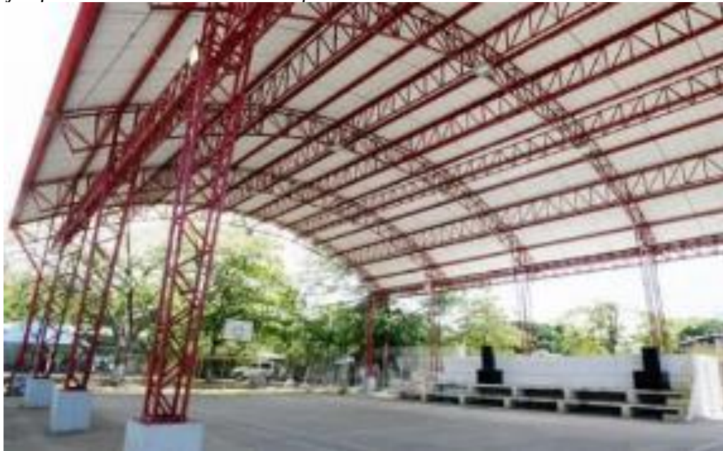
Figura 15. Ejemplo de Cubierta en un Polideportivo
