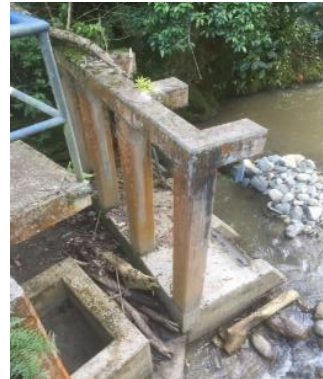
Figura 4 Vista estructura de captación de la bocatoma.
