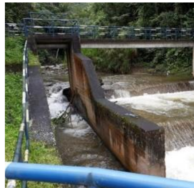
Figura 6 Vista general muros de protección. Fuente: presente estudio.
