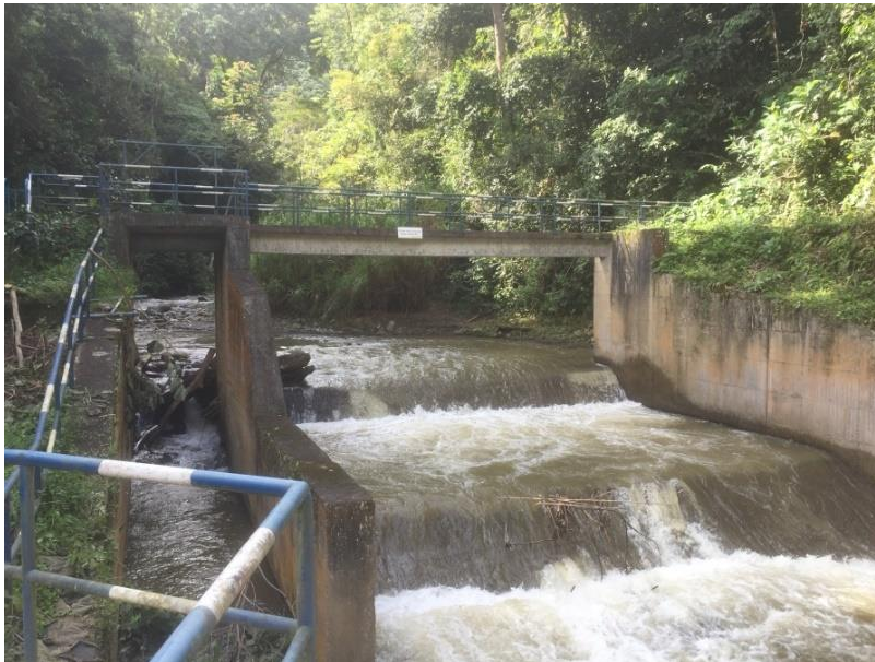
Figura 11 Vista general bocatoma.
