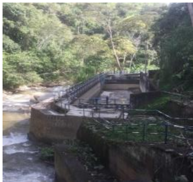
Figura 5 Vista general de acceso y desarenador N°1 de la bocatoma. .
