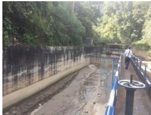
Figura 9 Vista desarenadores. Fuente: presente estudio.
