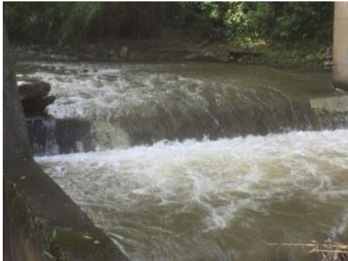
Figura 3 Vista dique de la Bocatoma.
