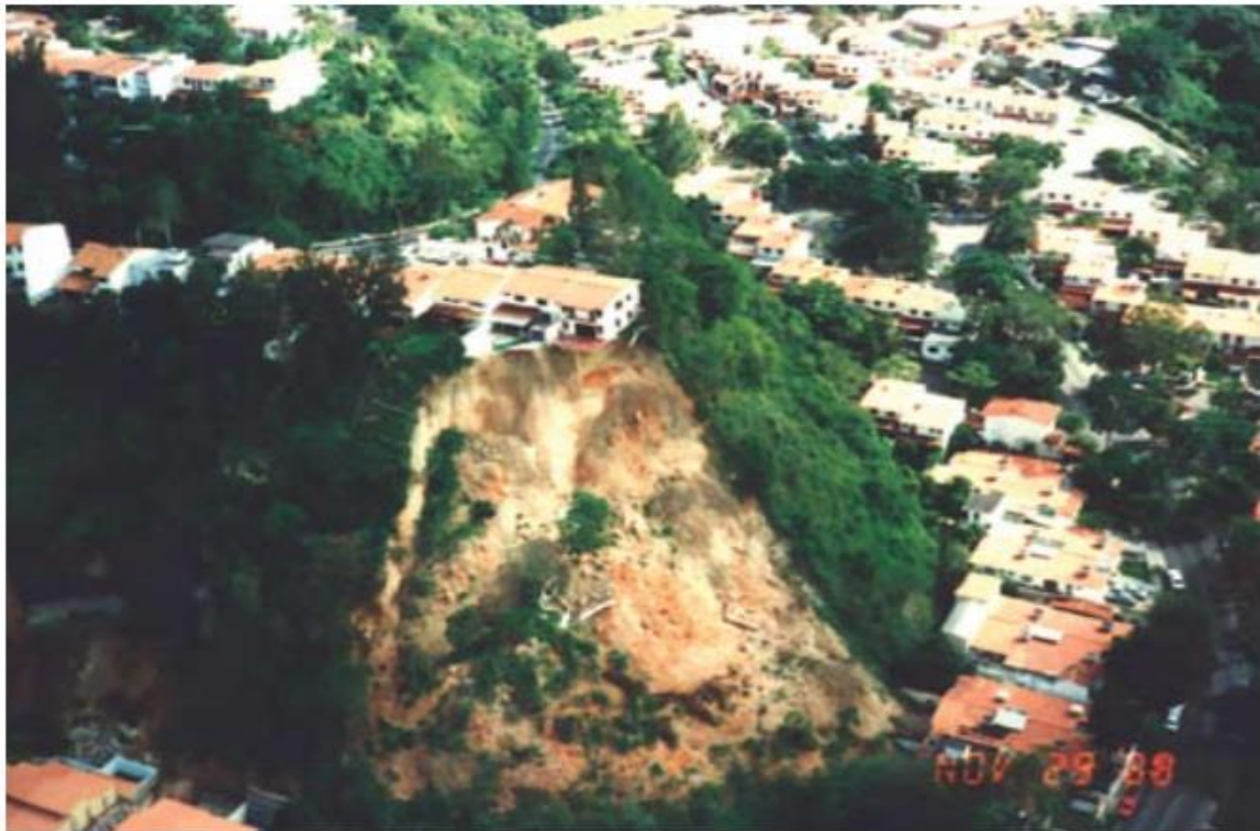
Figura 8. Deslizamiento compuesto, zona urbana.
