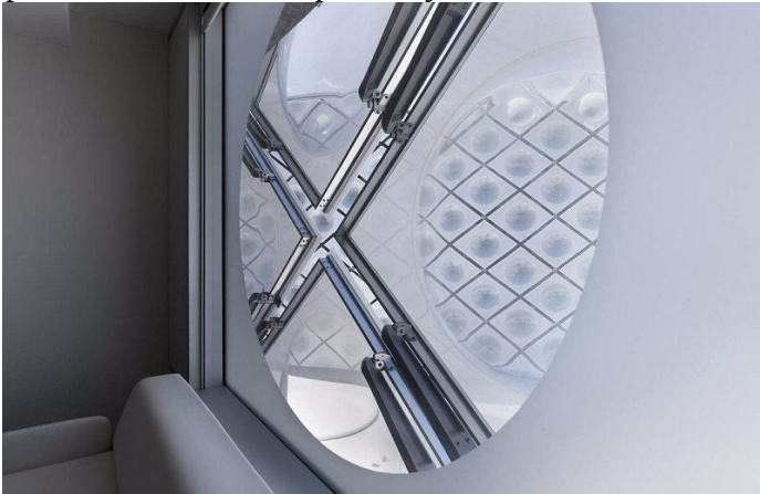
Figura 30. Vista detalle paneles de vidrio Hospital Rey Juan Carlos Móstoles
