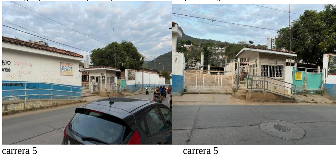
Figura 15. Fotografía Entrada principal del actual Hospital Regional de San Gil
