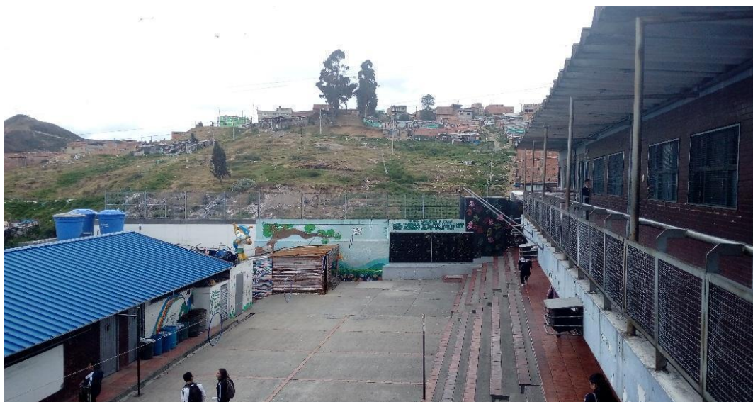
Imagen 4. Registro fotográfico zona natural desde sede B.
