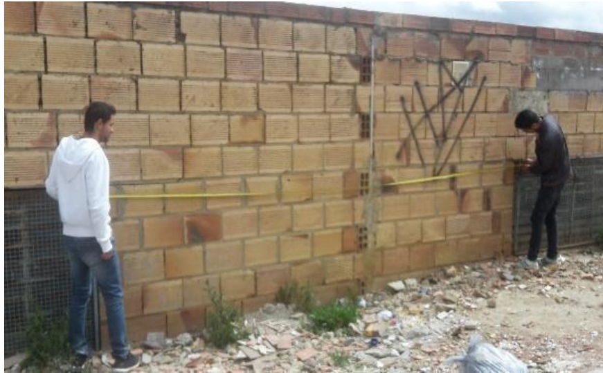
Ilustración 2. Medición de la longitud de los muros
