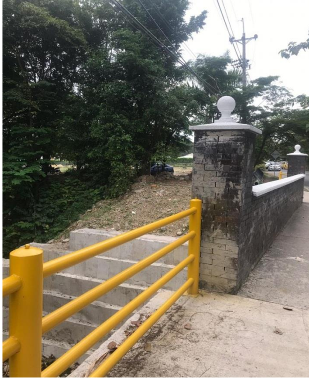
Estructura puente Caño Buque.
