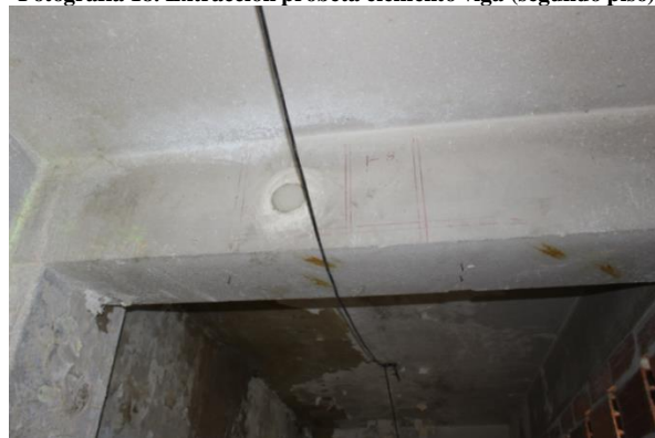
Fotografía 18. Extracción probeta elemento viga (segundo piso)
