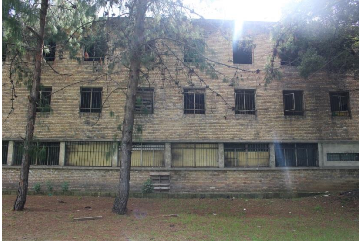
Fotografía 14. Parte lateral norte del Bloque 5B
