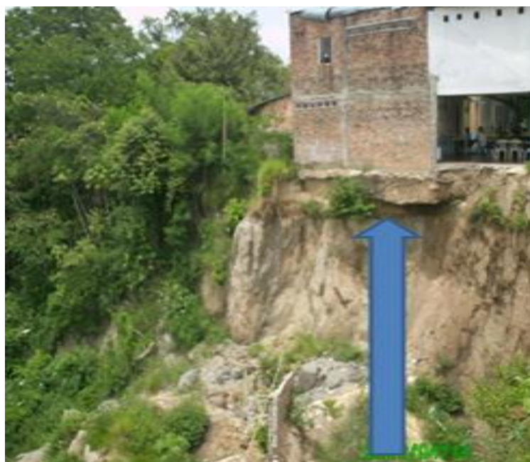
Ilustración 7 DESLIZAMIENTO POR AGUAS NEGRAS
