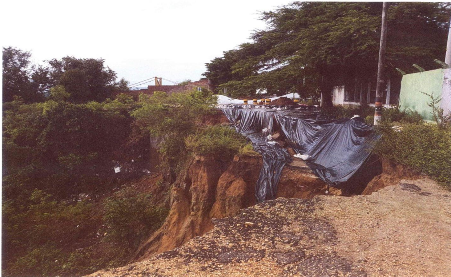
Ilustración 38 ZONA DE EROSIÓN
