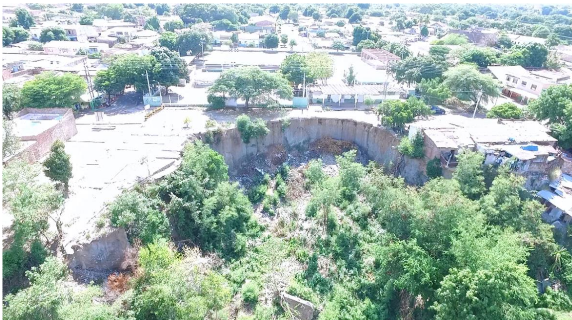
Ilustración 2 ZONA DE EROSIÓN SITUACIÓN ACTUAL
