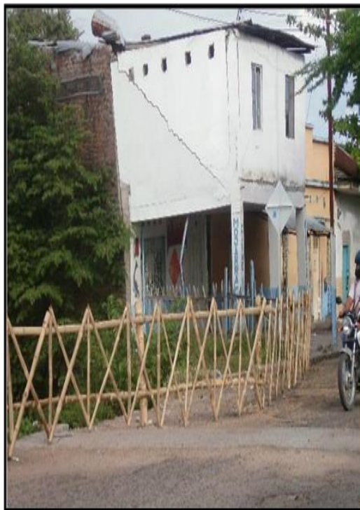
Ilustración 8 CAÍDA DE LA VÍA
