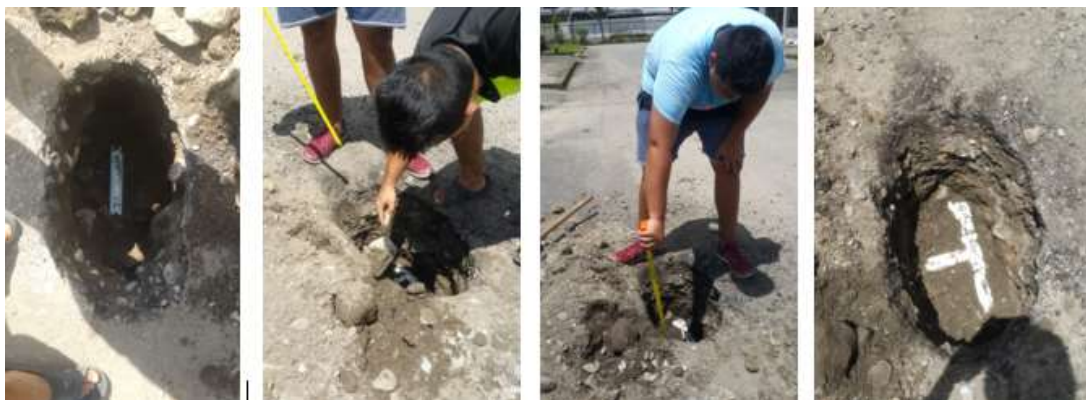
Figura 3-5. Apiques para identificar diámetros de tubería, profundidades y accesorios de la red existente. Fuente: Elaboración propia.
