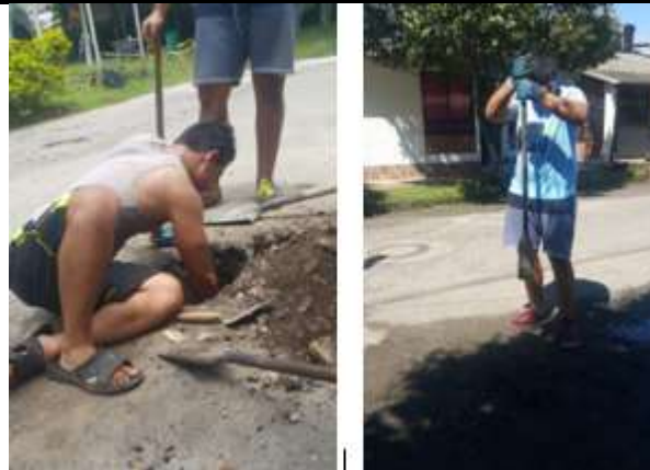
Figura 3-4. Excavación manual para identificar la red de suministro actual de la Urbanización. Fuente: Elaboración propia.
