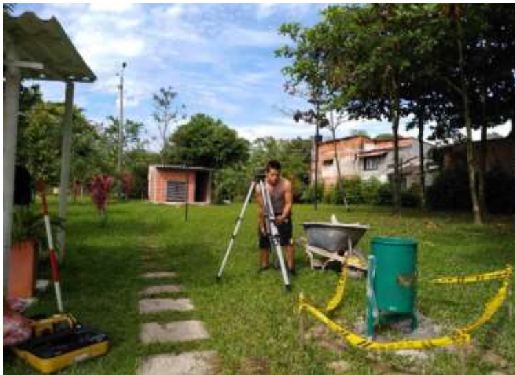
Figura 3-1. Armado de la estación total. Fuente: Elaboración propia.
