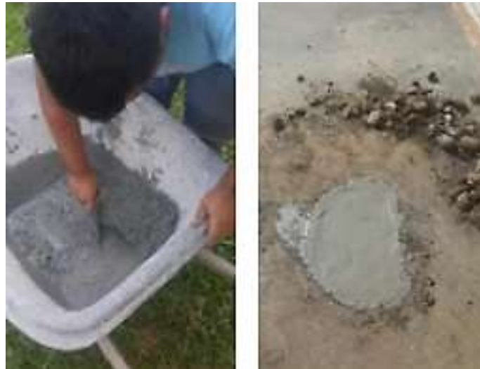
Figura 3-7. Parcheo con mezcla de 400 \text{ Kg/cm}^2 . Fuente: Elaboración propia.
