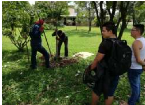
Figura 3-32. Apique realizado para el sondeo 1. Fuente: Elaboración propia.
