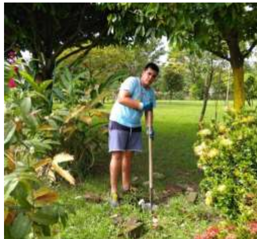
Figura 3-3. Sondeo para verificar la tubería de salida desde el cuarto de bombas a la red de suministro. Fuente: Elaboración propia.
