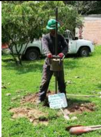
Figura 3-33. Perforación por percusión, sondeo 2. Fuente: Elaboración propia.
