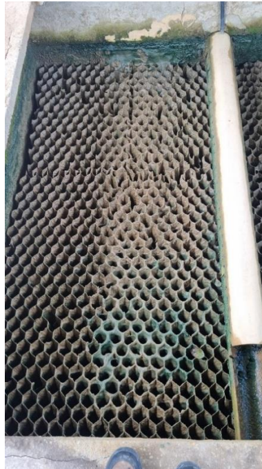
Figura 11. Celdas del sedimentador
