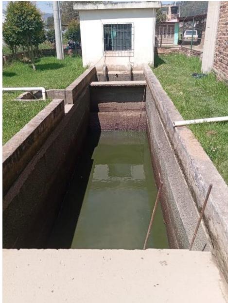
Figura 6. Desarenador
