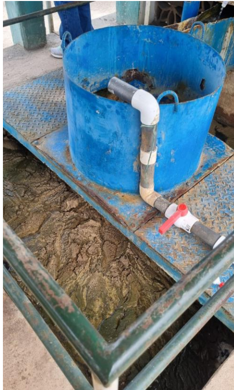
Figura 9. Sistema de floculación
