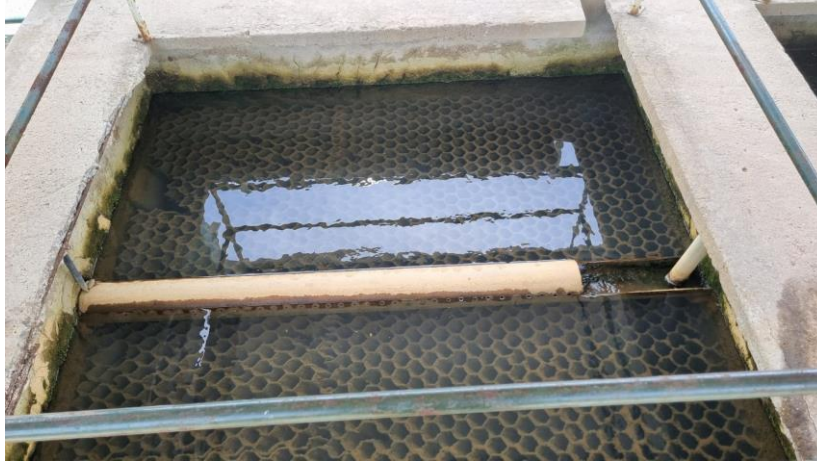
Figura 10. Sistema de sedimentación
