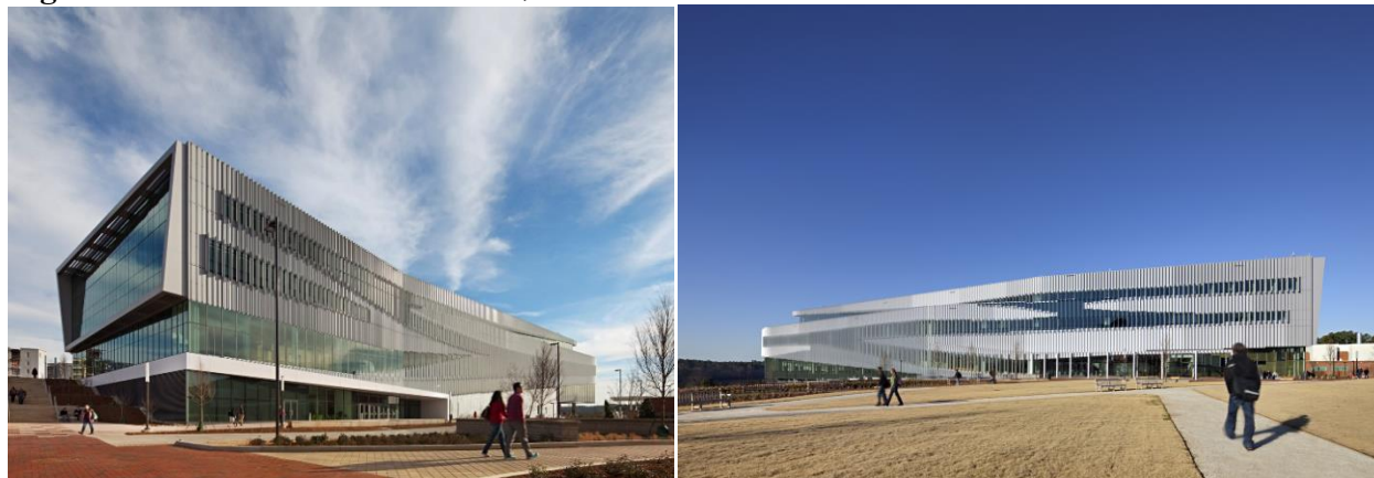
Figura 13. Biblioteca James B. Hunt, Universidad Estatal de Carolina del Norte. Vistas exteriores
