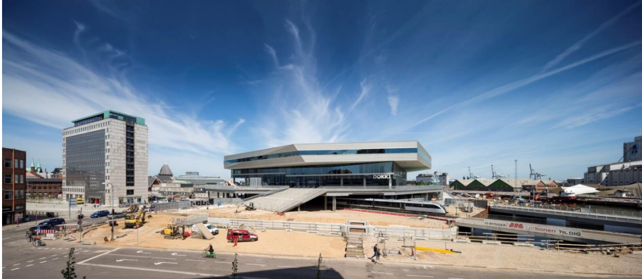
Figura 3. Dokk1 – Centro Cultural y Biblioteca Urbana en Aarhus, Dinamarca. Vista exterior
