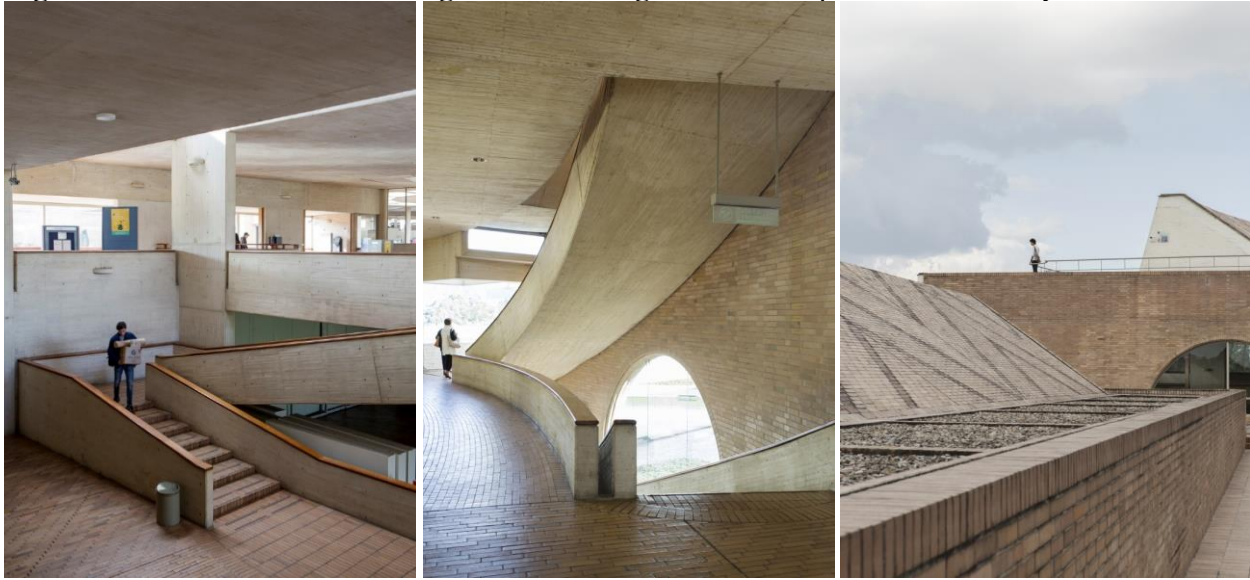
Figura 46. Biblioteca Pública Virgilio Barco, Bogotá. Vistas espacios interiores y terraza
