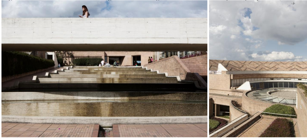
Figura 45. Biblioteca Pública Virgilio Barco, Bogotá. Vista del acceso principal y terraza
