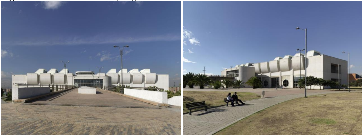
Figura 37. Biblioteca El Tintal, Bogotá. Vistas exteriores
