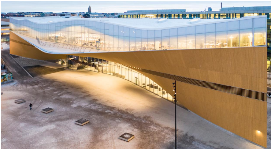
Figura 36. Acceso principal Biblioteca Oodi.
