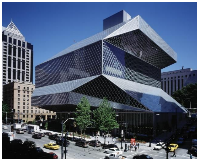
Figura 4. Biblioteca Central de Seattle
