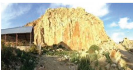
Figura 1. Talud del caso de estudio.
