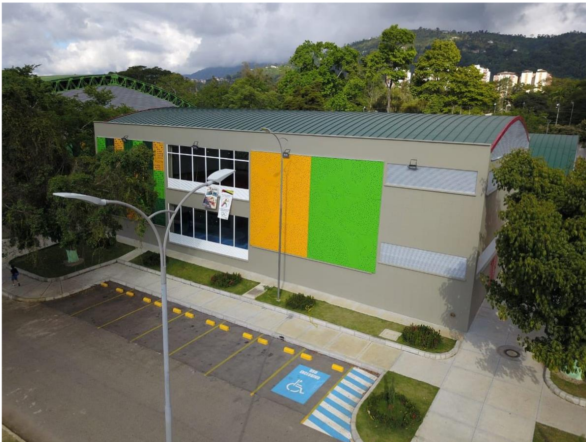
Figura 9. Vista exterior /coliseo de combate Bucaramanga.
