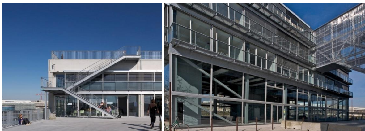
Figura 24. Fotografías exteriores de la escuela nacional superior de arquitectura.
