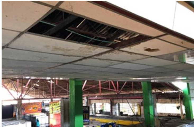
Figura 52. Estado Actual, cubierta y cielo raso.
