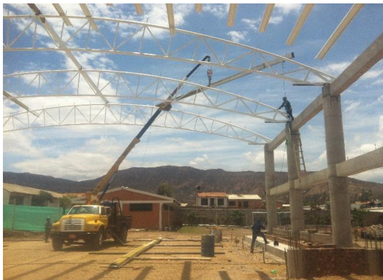
Ilustración 30. Montaje de correas.
