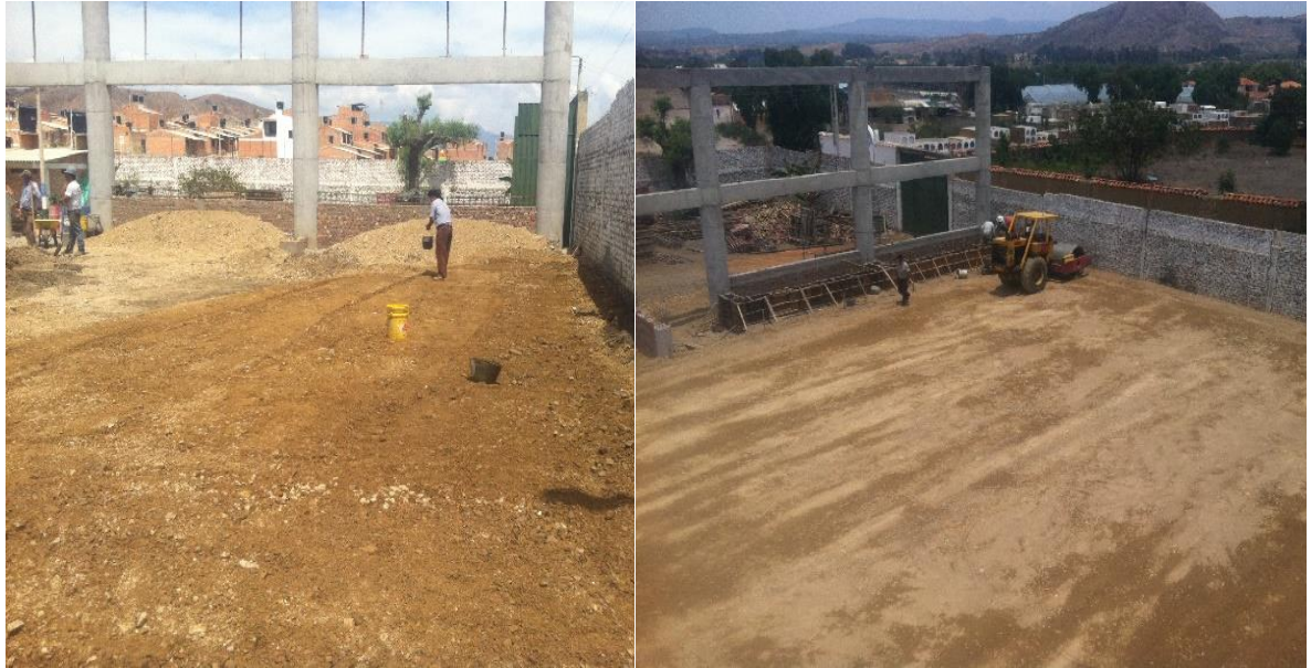
Ilustración 24. Mejoramiento de suelo.
