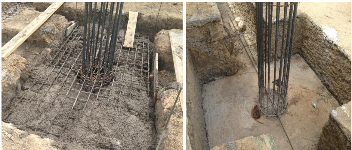
Ilustración 17. Concreto de zapatas.
