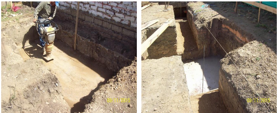
Ilustración 11. Compactación material granular
