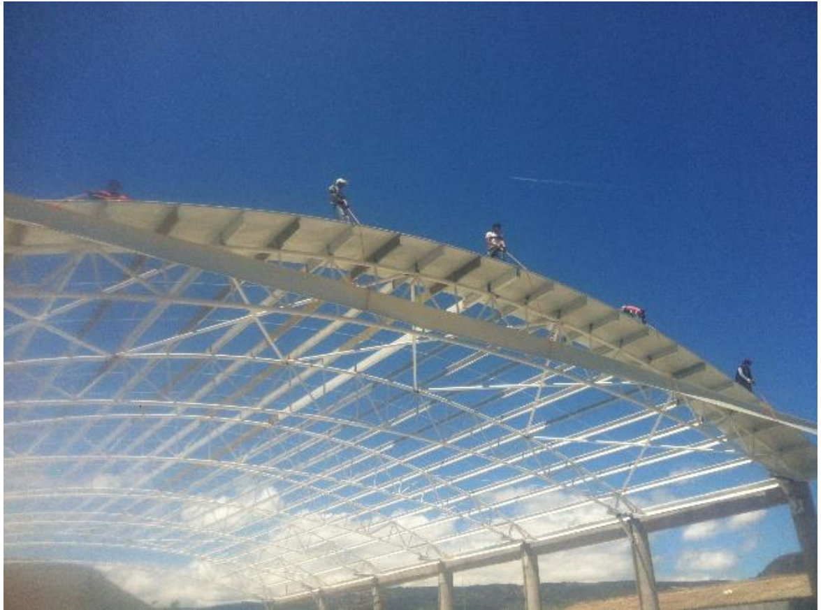
Ilustración 50. Montaje teja.
