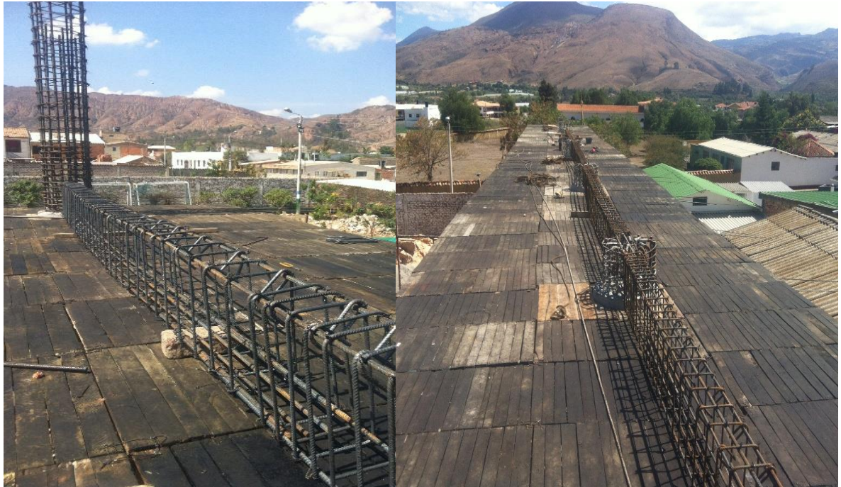
Ilustración 21. Refuerzo de vigas aéreas.
