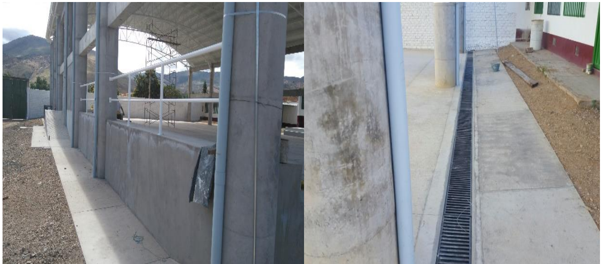
Ilustración 52. Andenes en concreto.
