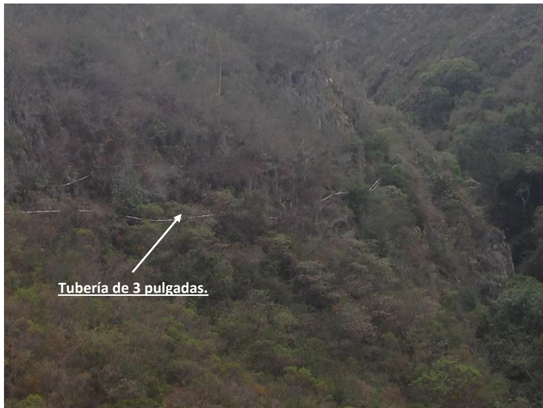
Ilustración 59. Tubería red de aducción.
