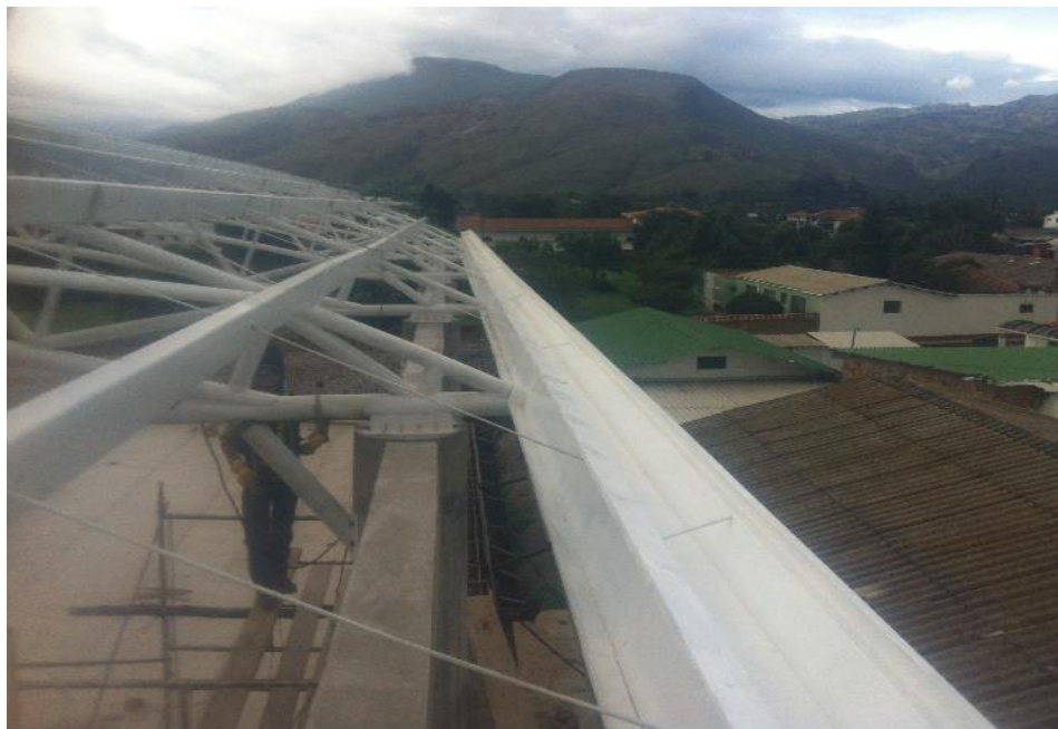
Ilustración 34. Rigidizadores cubierta.
