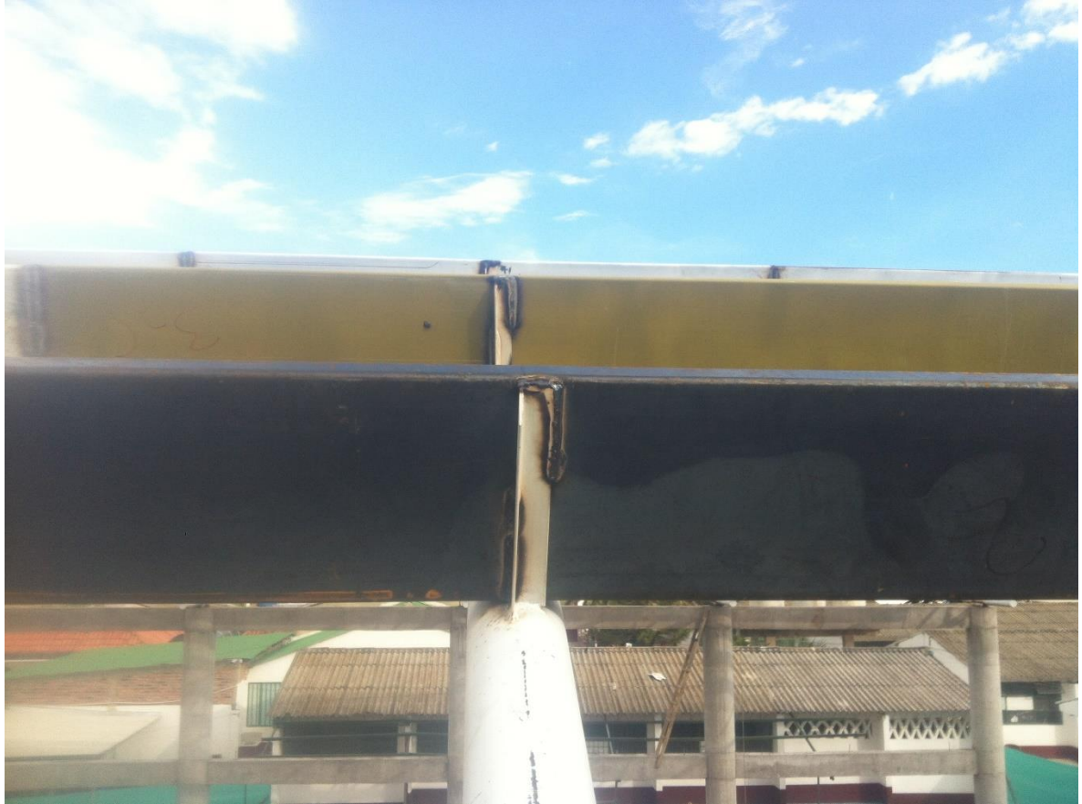
Ilustración 35. Cordón de soldadura.
