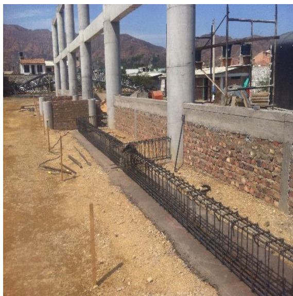
Ilustración 40. Refuerzo y concreto VGR-02.
