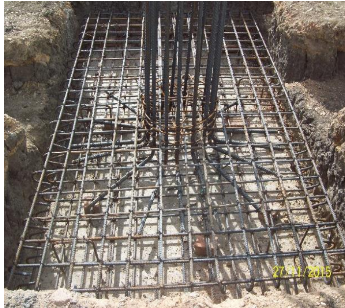
Ilustración 13. Refuerzo zapatas eje 1.
