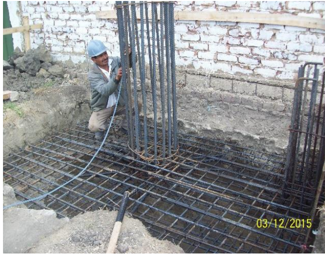
Ilustración 14. Refuerzo de columnas.
