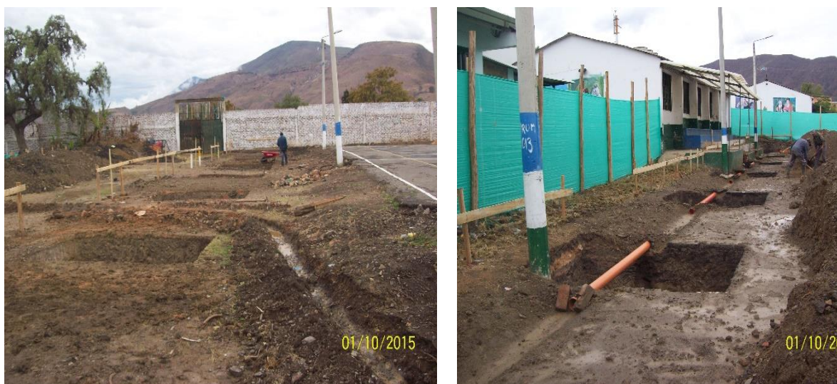
Ilustración 9. Excavaciones Zapatas eje 1 y 2.
