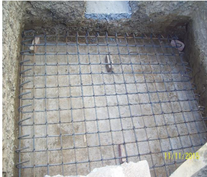
Ilustración 12. Refuerzo zapatas eje 2.
