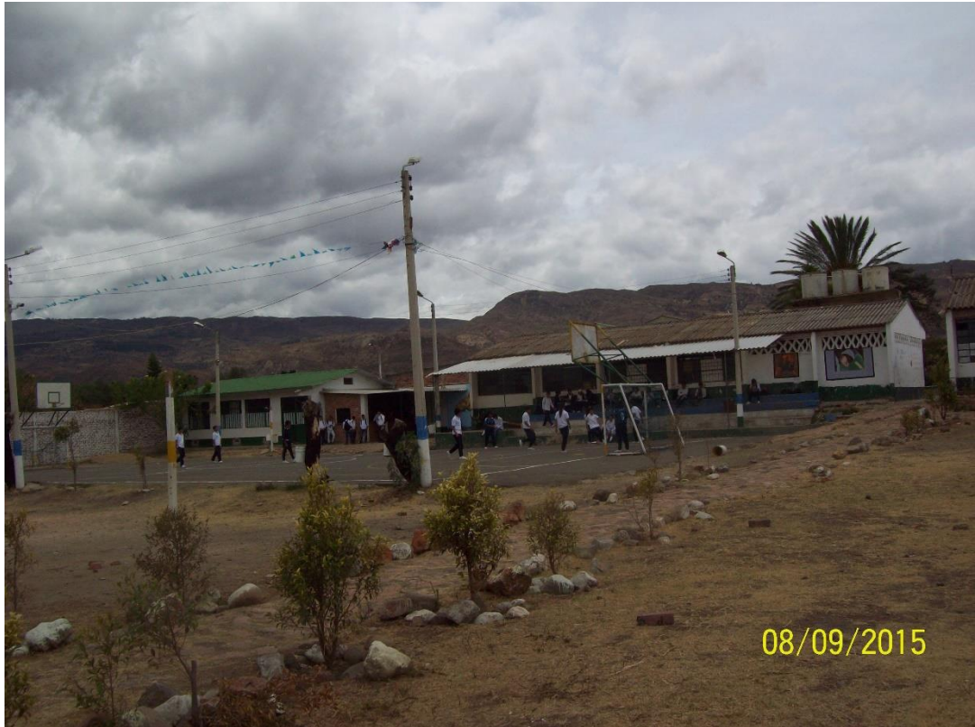
Ilustración 7. Postes de iluminación.
