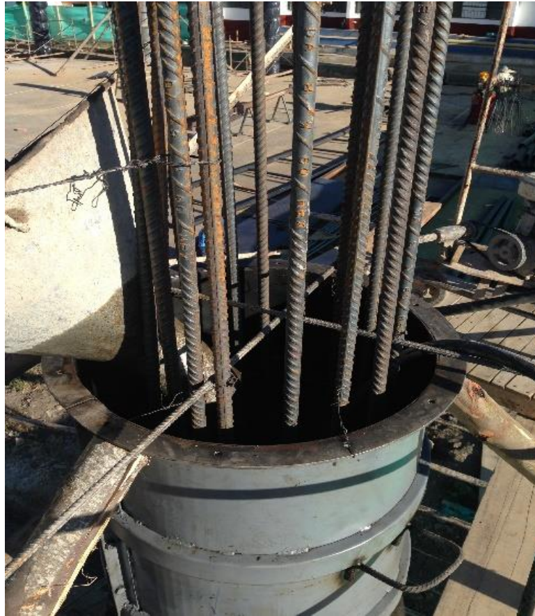
Ilustración 19. Fundida de columnas.
