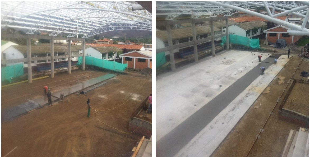
Ilustración 44. Placa base de concreto.
