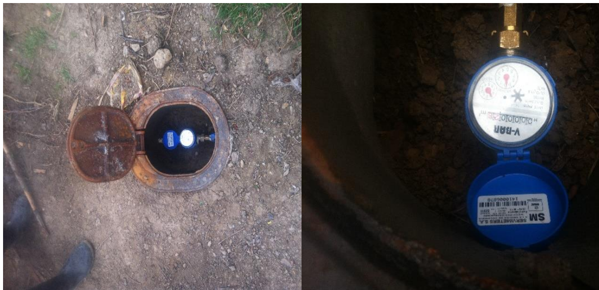
Ilustración 67. Micromedidores.
