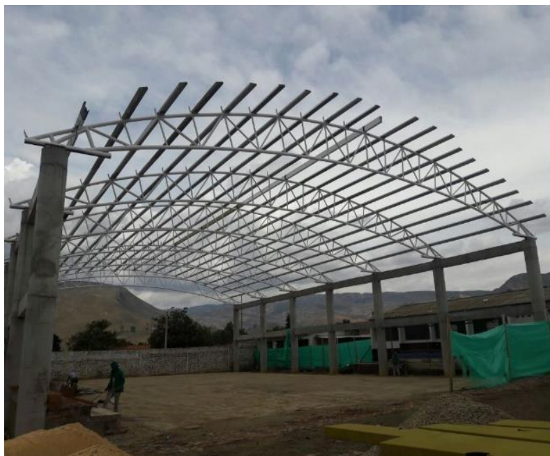
Ilustración 29. Cerchas montadas.
