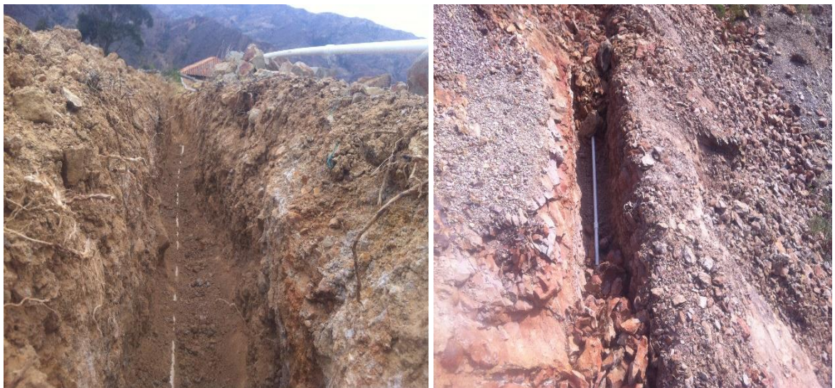
Ilustración 64. Excavaciones red de suministro.
