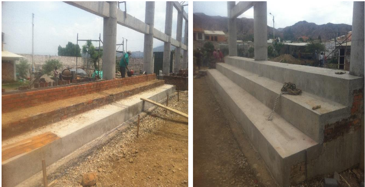
Ilustración 41. Construcción de graderías.
