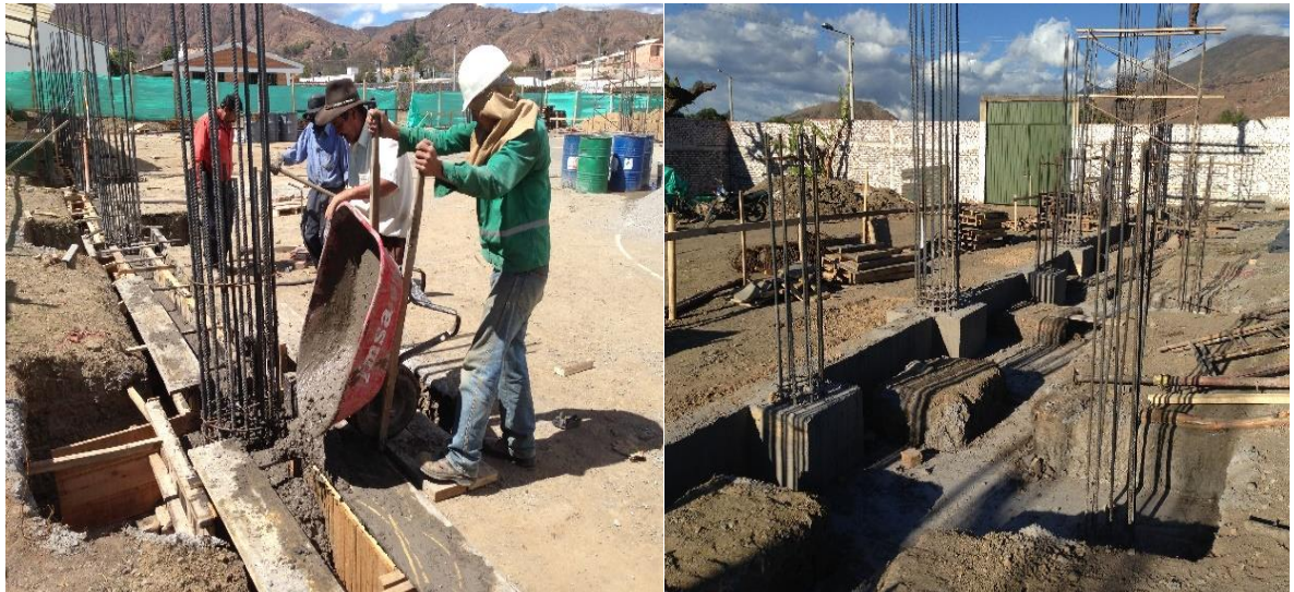
Ilustración 18: concreto vigas de cimentación.
