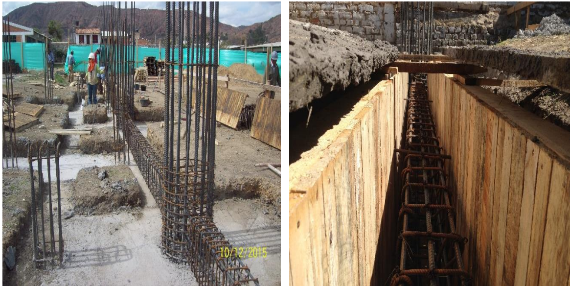
Ilustración 16. Refuerzo vigas de cimentación.
