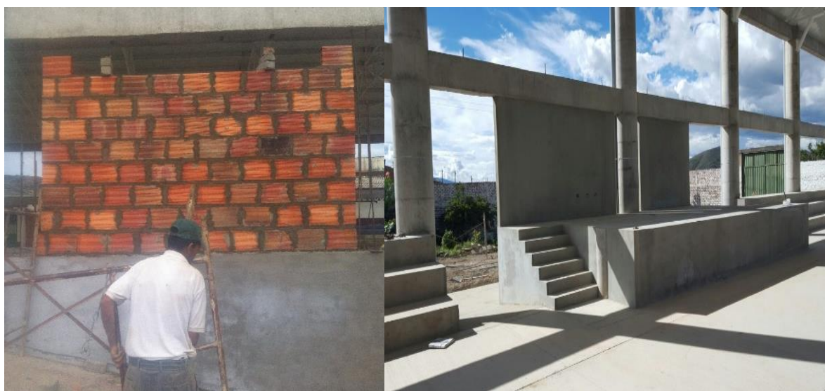
Ilustración 53. Muros sobre tarima.
