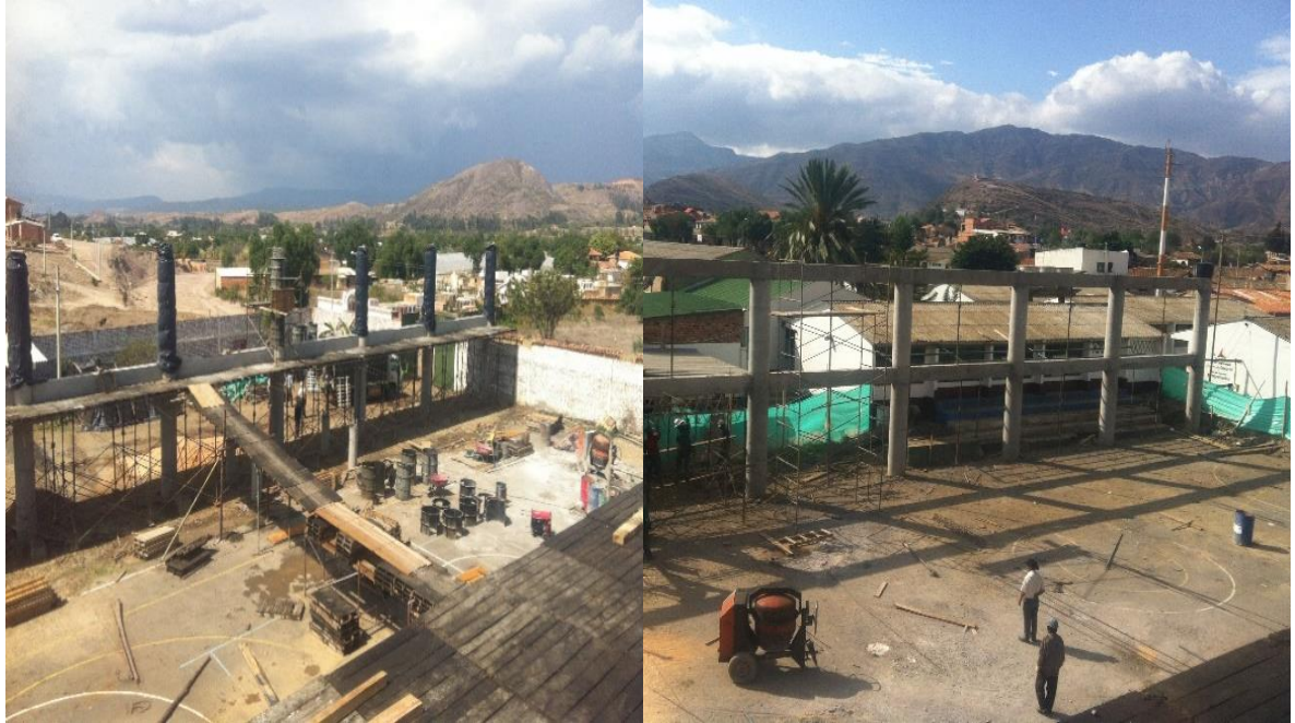
Ilustración 22. Pórtico estructural de concreto.
