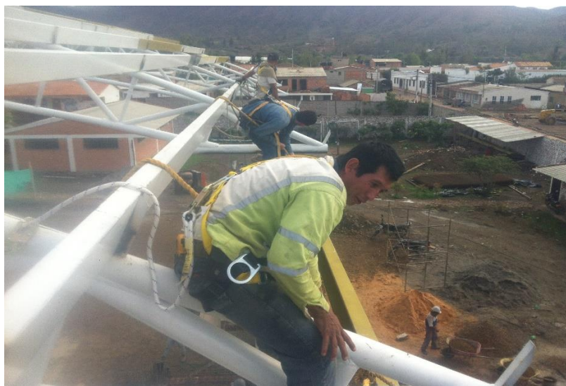
Ilustración 31. Seguridad de trabajadores.
