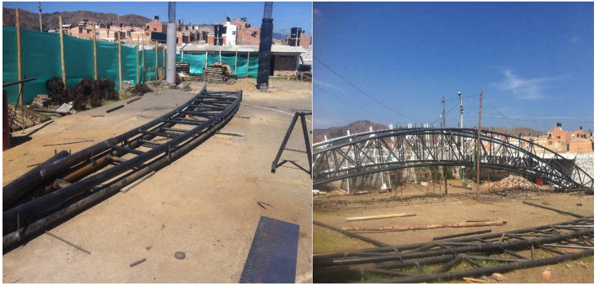
Ilustración 26. Cerchas de cubierta.
