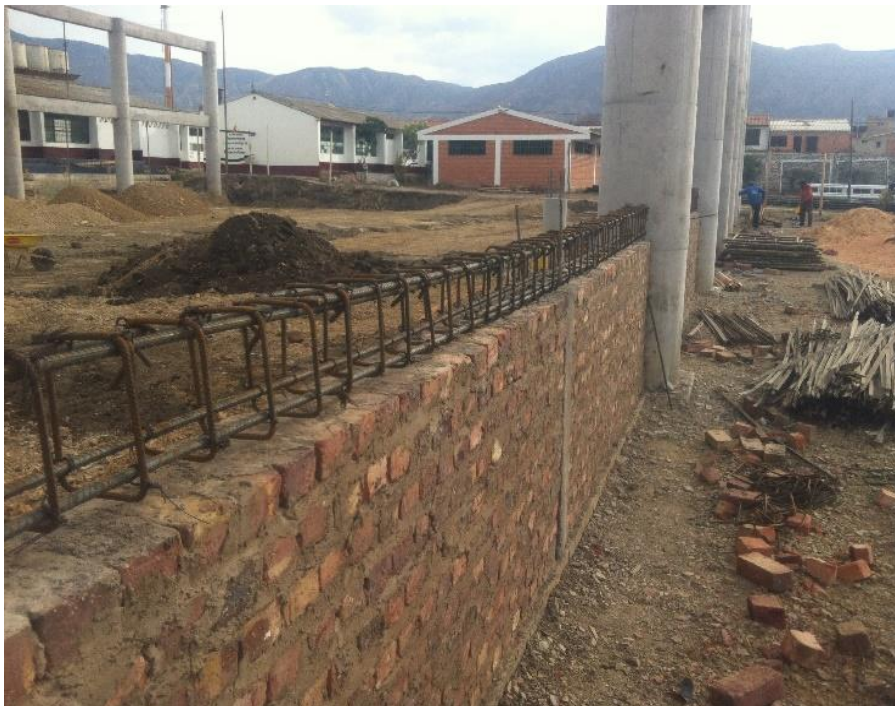
Ilustración 38. Refuerzo VGR-03
