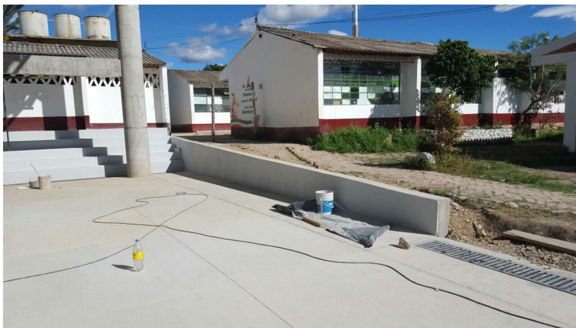
Ilustración 45. Muro de contención.
