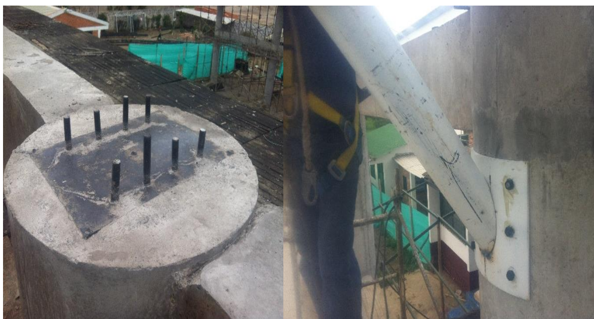
Ilustración 27. Platinas de estructura de cubierta.
