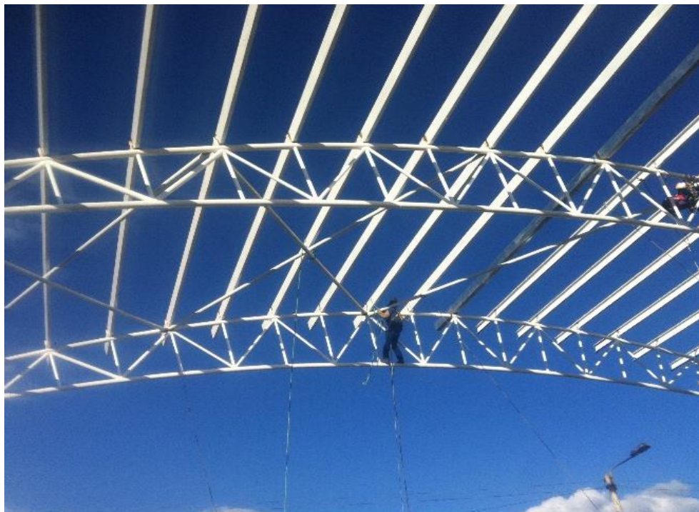
Ilustración 33. Rigidizadores cubierta.
