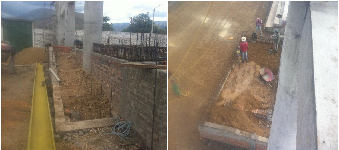
Ilustración 43. Relleno granular (recebo).
