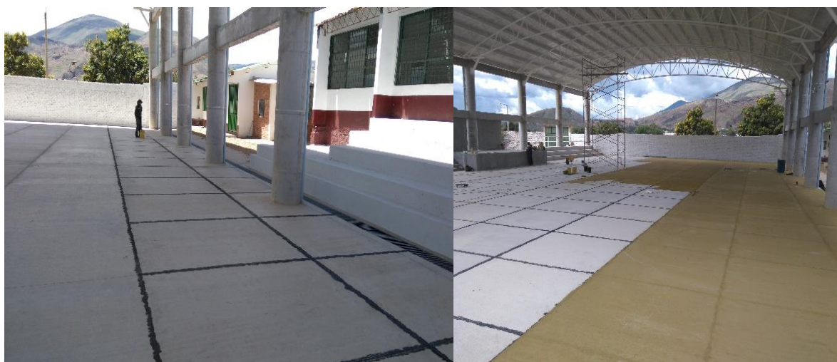
Ilustración 56. Sellado de juntas y mortero.
