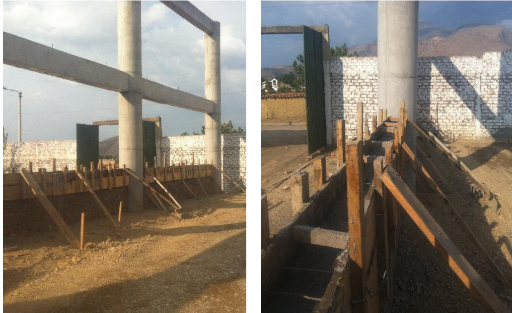
Ilustración 39. Formaleta vigas.
