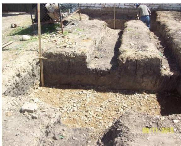
Ilustración 10. Excavación vigas de cimentación.
