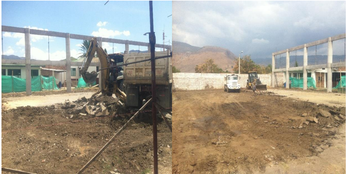
Ilustración 23. Excavación y retiro de suelo.
