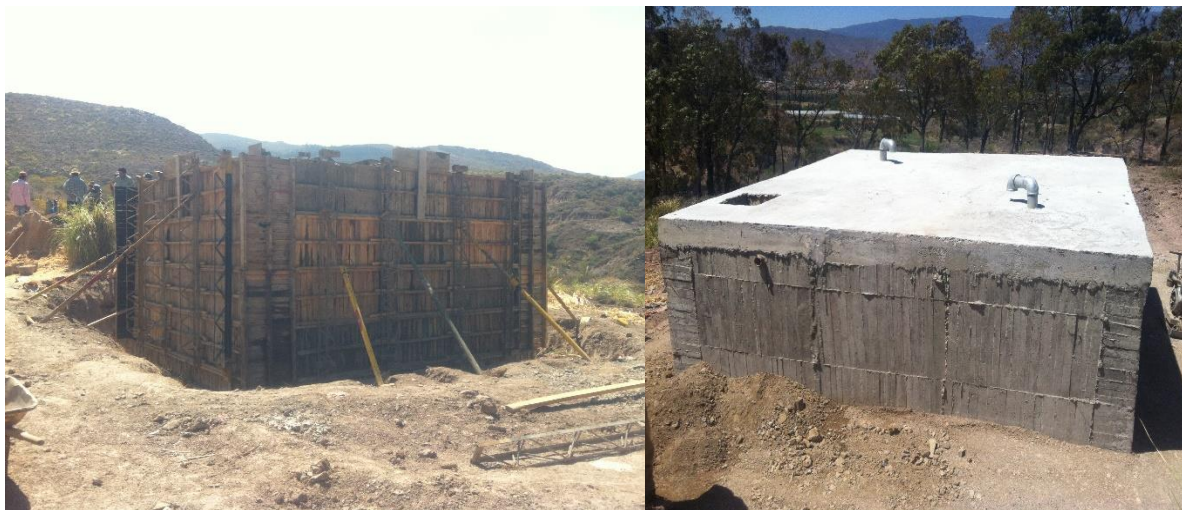
Ilustración 69. Tanque fundido.
