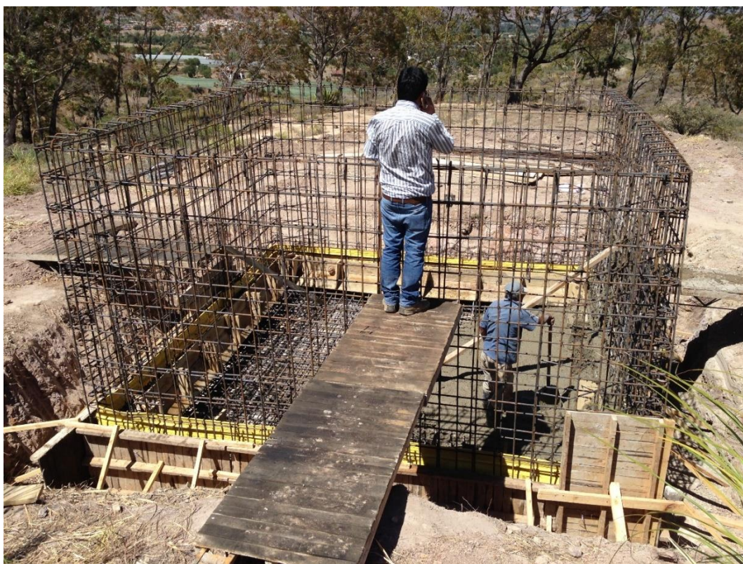
Ilustración 68. Refuerzo tanque de almacenamiento.
