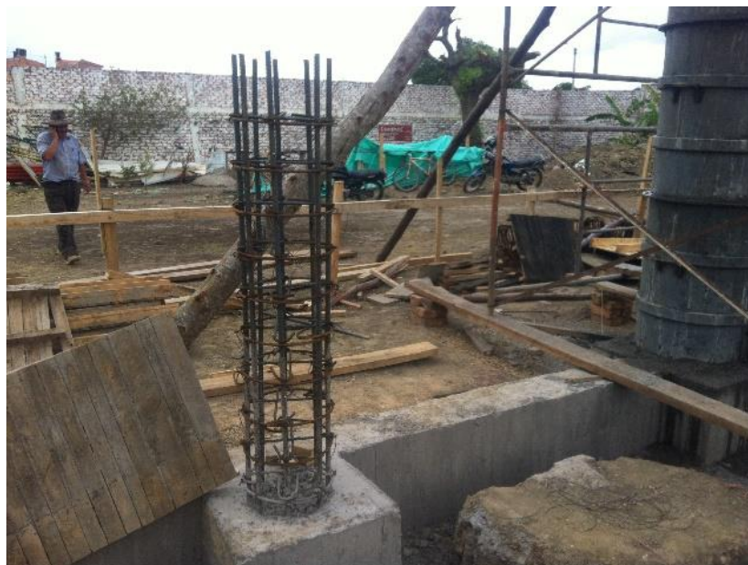
Ilustración 15. Refuerzo columnas de tarima.
