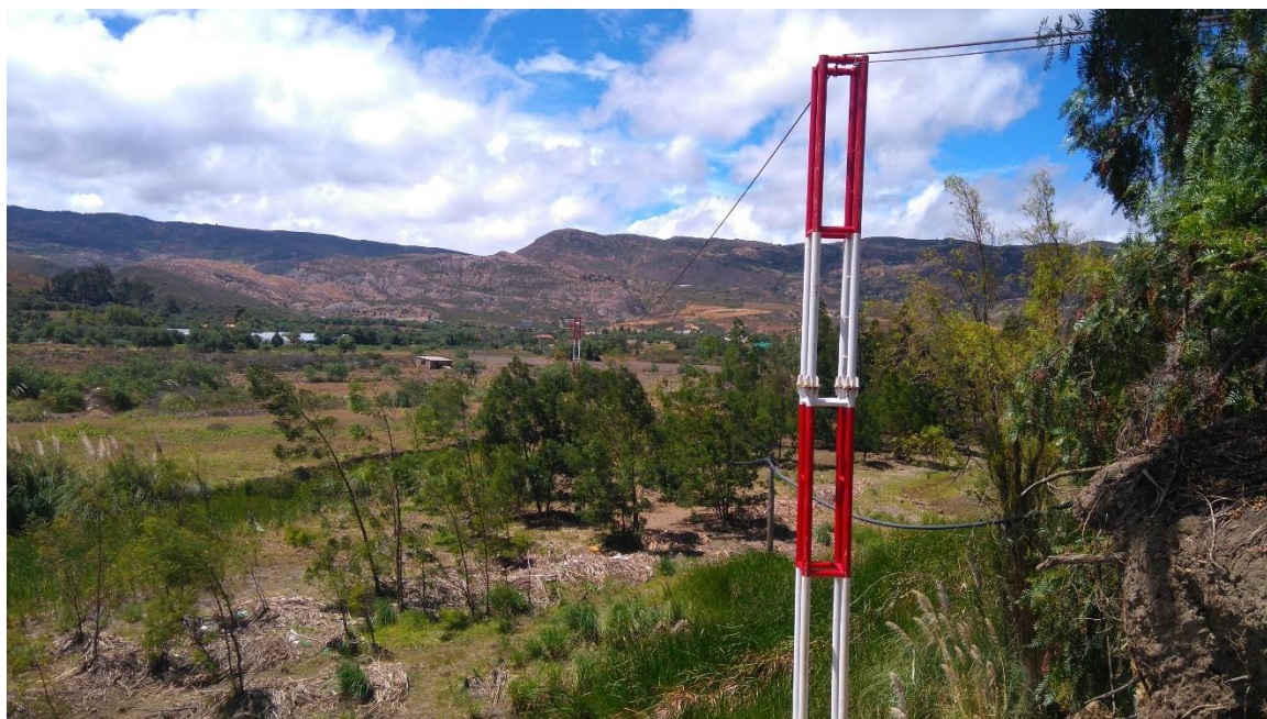
Ilustración 72. Paso elevado del acueducto Las Manitas.
