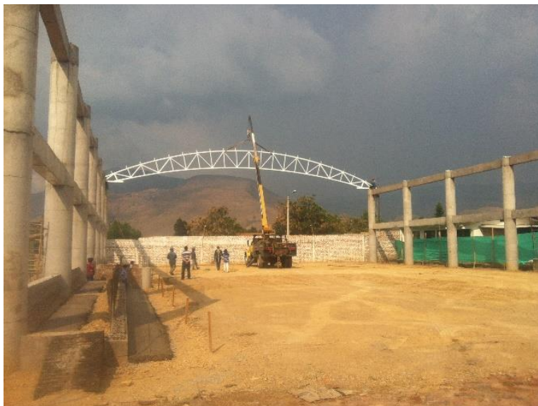
Ilustración 28. Montaje de cerchas.
