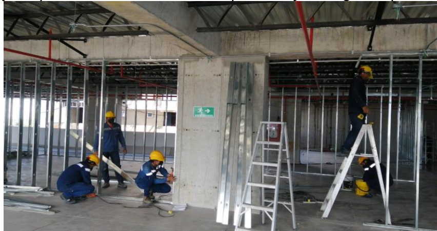
Figura 8 Manejo de personal obra civil centro empresarial y de negocios potencia
