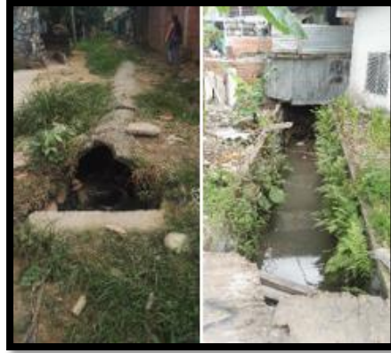
Imagen 4-4 Alcantarillado actual. Fuente Autores
