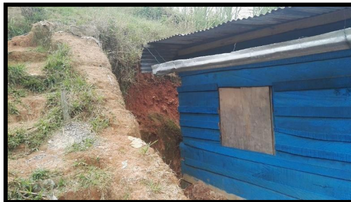
Imagen 4-2 Vivienda con fachada en madera. Fuente Autores.
