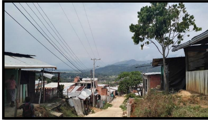
Imagen 4-6 Redes de energía a lo largo del asentamiento. Fuente Autores
