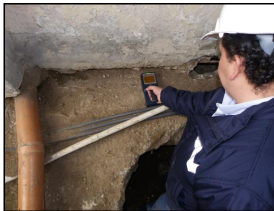
Figura 10. Medición con Wall Scanner. Fuente: Propia
