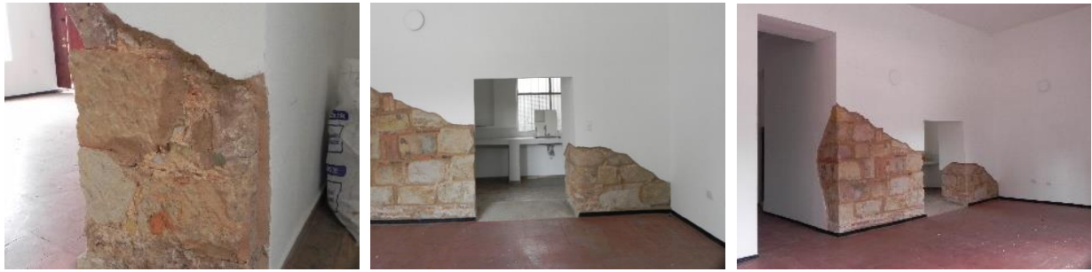
Figura 40. Imágenes de evidencia de mampostería en pierda de sillar.
