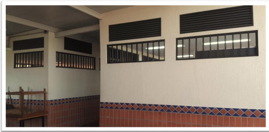
Fotografía #2 tomada en sitio
