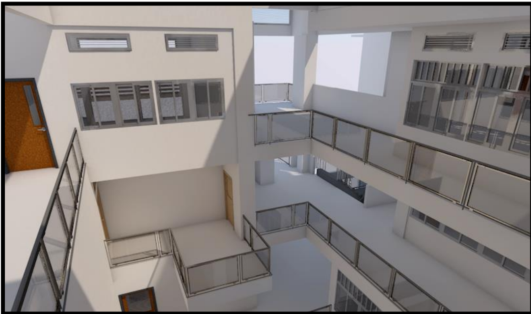
Figura 157. Fotografía de vacío (ojo) vista desde la planta 6 al exterior
