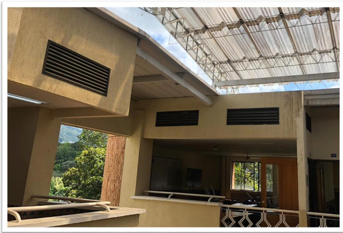
Figura 66. Fotografía de la estructura sexto piso
