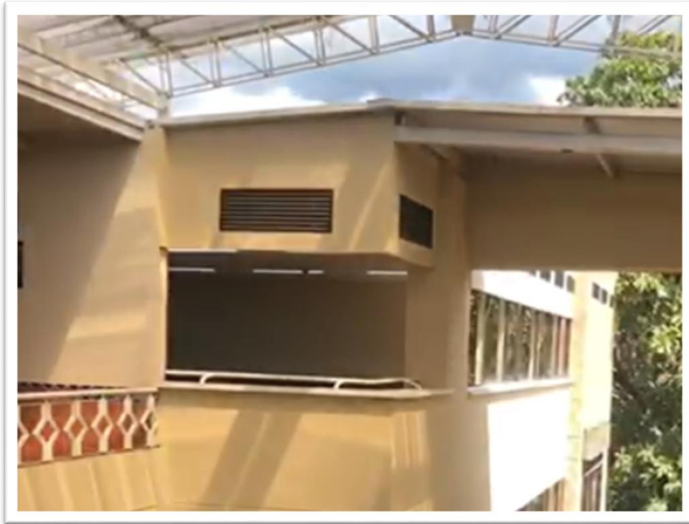
Figura 68. Fotografía de la estructura sexto piso
