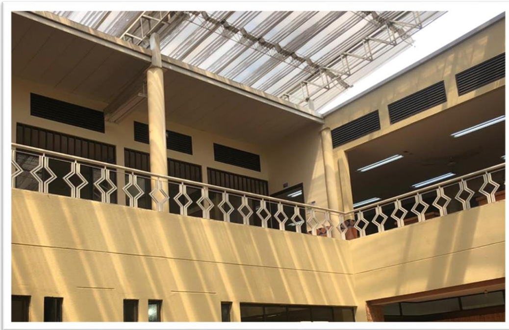
Fotografía #1 tomada en sitio
