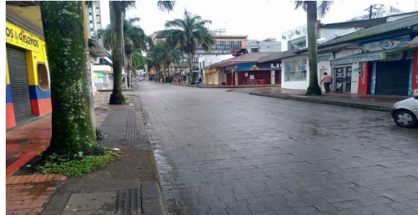
Ilustración 6. TRAMO VIAL CALLE 37- CALLE 38. CONCRETO ESTAMPADO
