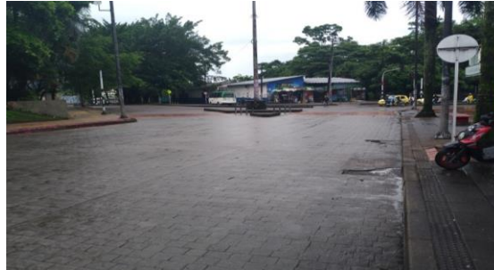
Ilustración 5. TRAMO VIAL CALLE 35- CALLE 37. CONCRETO ESTAMPADO
