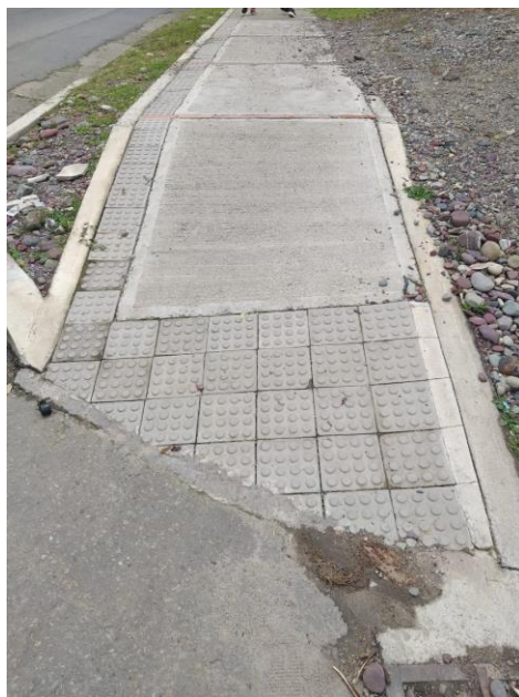
Figura 8.14 Rampa de acceso al Tramo G (Julio 2020)
