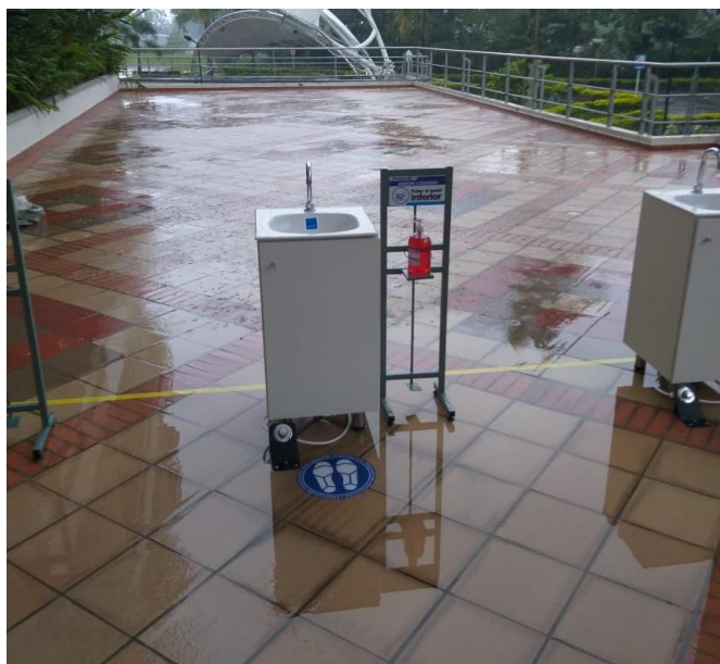
Figura 8.30 Inundación en el lobby del bloque A (Julio 2020) Fuente: Elaboración propia a partir de inspección
