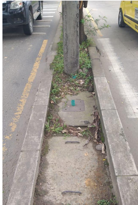
Figura 8.16 Separador de Cruce peatonal – Tramo I y J (Julio 2020) Fuente: Elaboración propia a partir de inspección
