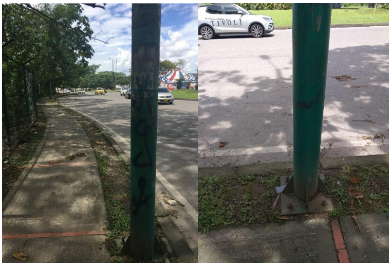
Figura 8.5 Ubicación de postes de luz en Tramos A y B (Julio 2020) Fuente: Elaboración propia a partir de inspección
