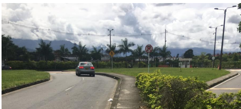
Figura 8.6 Ubicación de postes de luz en Tramo C (Julio 2020) Fuente: Elaboración propia a partir de inspección
