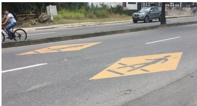
Figura 8.10 Demarcación “Proximidad de Cruce Peatonal” – Tramo H (Julio 2020) Fuente: Elaboración propia a partir de inspección
