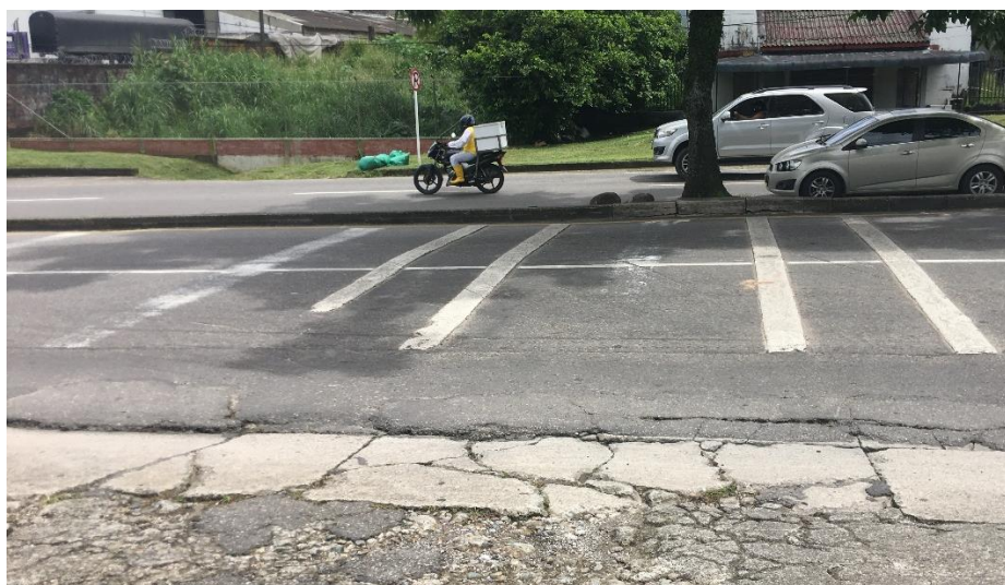
Figura 9.25 Reductor de velocidad – Tramo I (Julio 2020)
