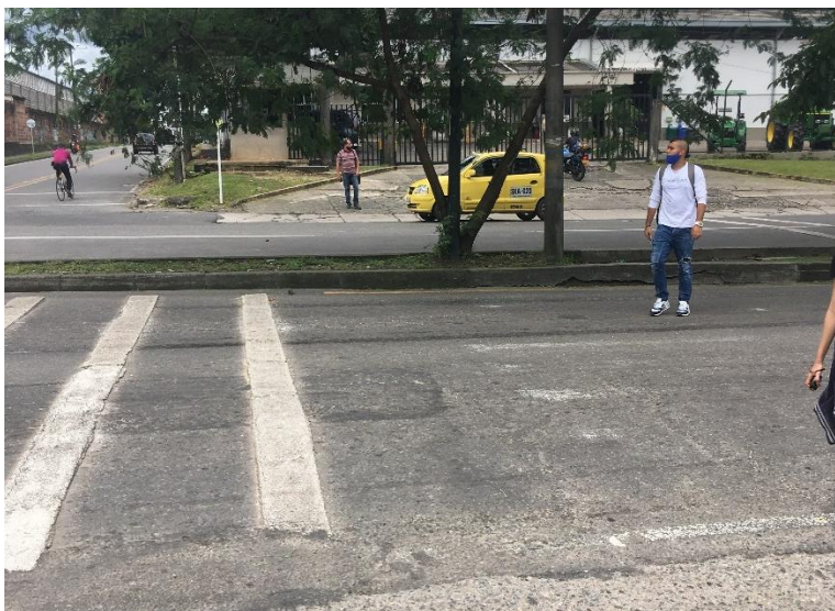
Figura 9.1 Cruce Peatonal entrada barrio Vizcaya (Julio 2020) Fuente: Elaboración propia a partir de inspección
