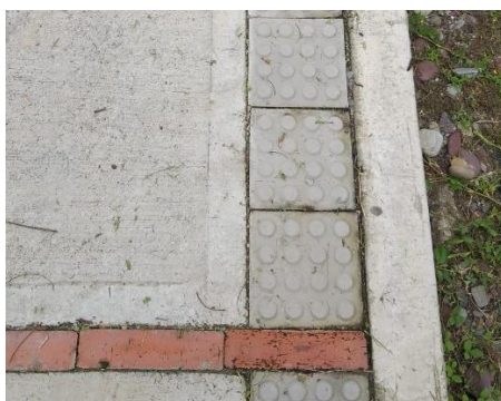
Figura 8.12 Guía podotáctil de alerta – Tramo G (Julio 2020) Fuente: Elaboración propia a partir de inspección
