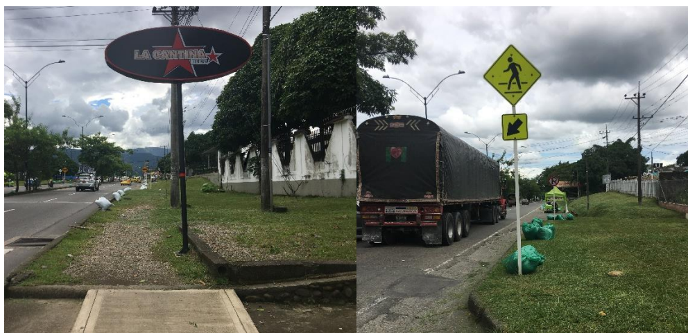
Figura 8.26 Señales viales y avisos – Tramo H y J (Julio 2020) Fuente: Elaboración propia a partir de inspección
