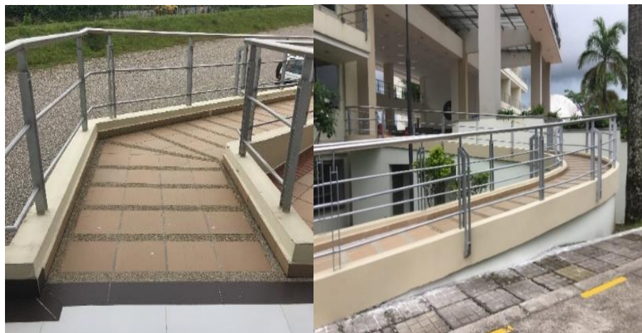
Figura 9.33 Izquierda Rampa F en el bloque B – Derecha Rampa G en el bloque A (Julio 2020) Fuente: Elaboración propia a partir de inspección
