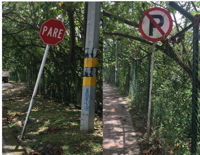
Figura 8.8 Señalización vial en el Tramo A (Julio 2020) Fuente: Elaboración propia a partir de inspección
