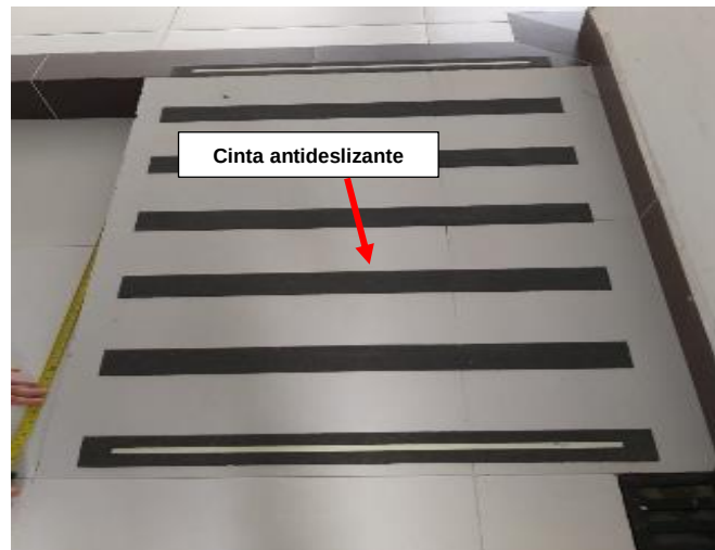
Figura 9.32 Rampa C ubicada en el sótano del bloque B (Julio 2020) Fuente: Elaboración propia a partir de inspección
