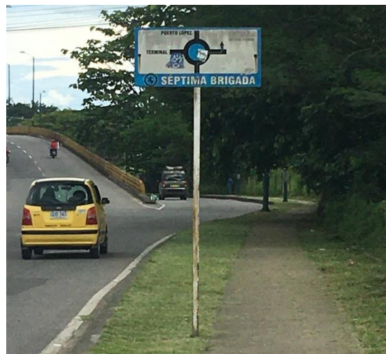
Figura 8.9 Señalización vial en el Tramo M (Julio 2020) Fuente: Elaboración propia a partir de inspección
