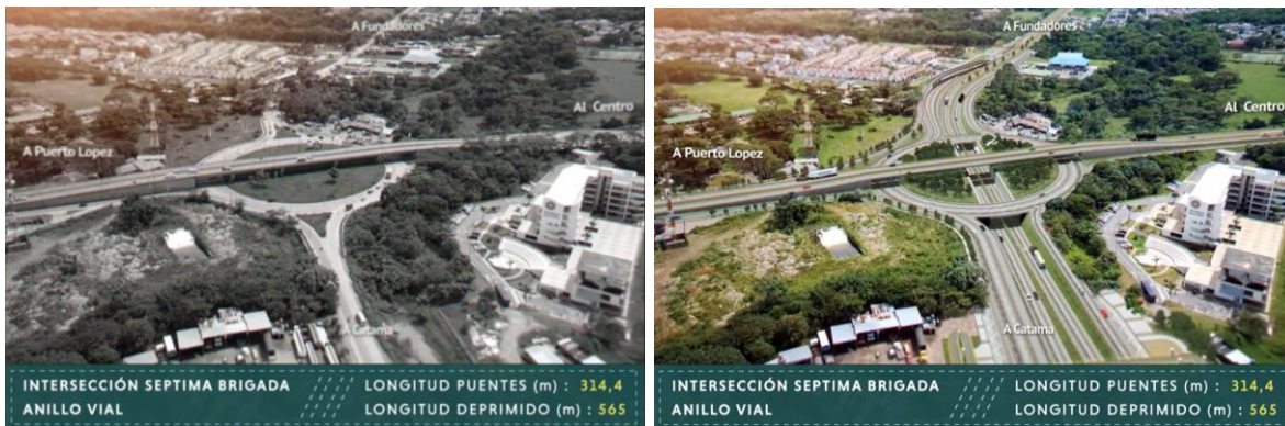
Figura 6.20 Séptima Brigada antes y “después” de la ejecución del proyecto Fuente: Agencia Nacional de Infraestructura (ANI) (2015)
