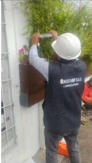
ENSAYO DE ESCLEROMETRO
