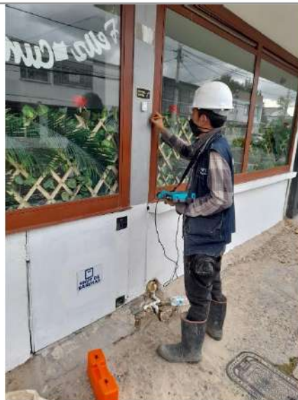
ENSAYO DE FERROSCAN
