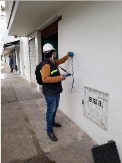
ENSAYO DE FERROSCAN
