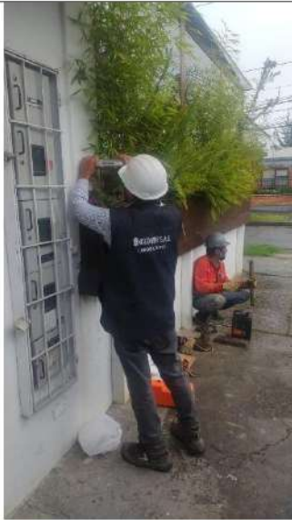
ENSAYO DE ESCLEROMETRO
