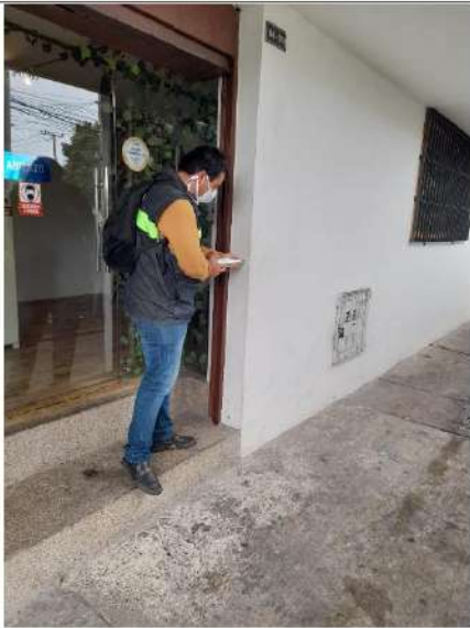
ENSAYO DE FERROSCAN
