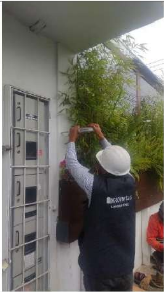
ENSAYO DE ESCLEROMETRO
