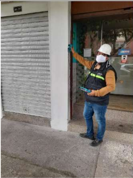
ENSAYO DE FERROSCAN
