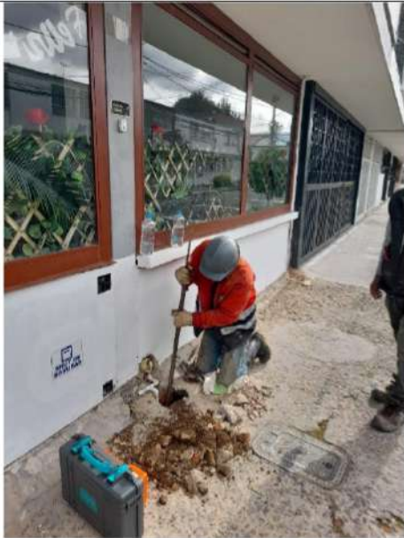
APIQUE DE RECONOCIMIENTO
