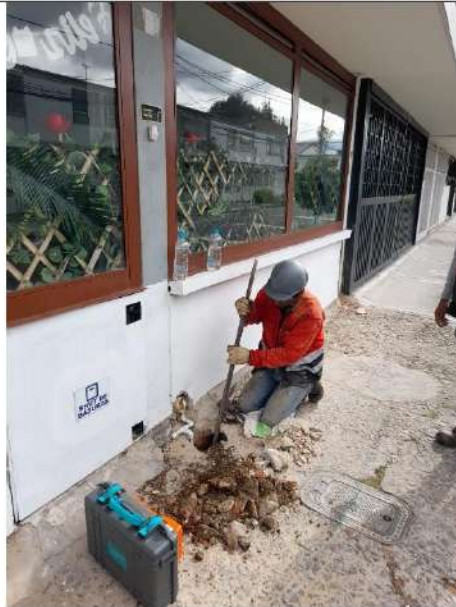
APIQUE DE RECONOCIMIENTO
