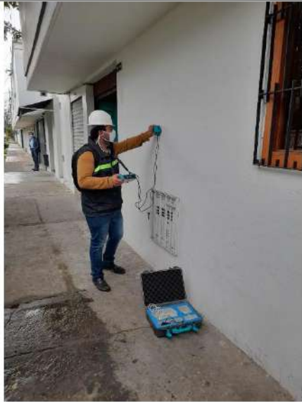
ENSAYO DE FERROSCAN
