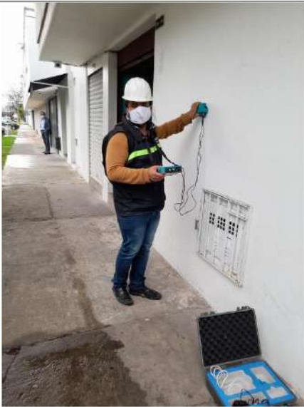
ENSAYO DE FERROSCAN
