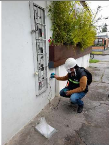
ENSAYO DE FERROSCAN
