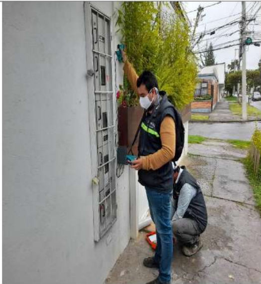
ENSAYO DE FERROSCAN
