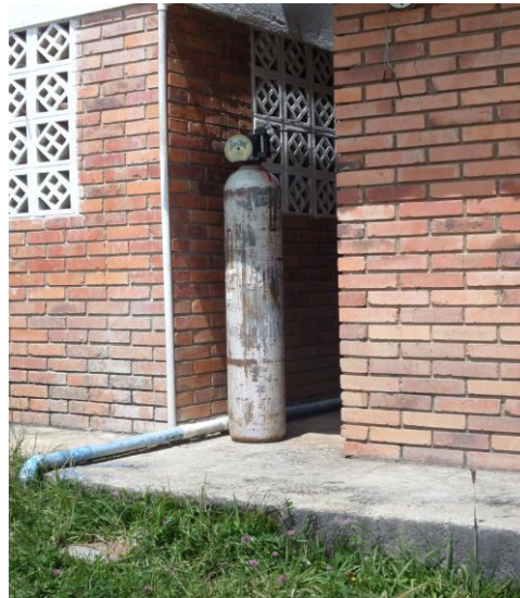
Imagen 8. Sistema de desinfección de la PTAP de Guatavita
