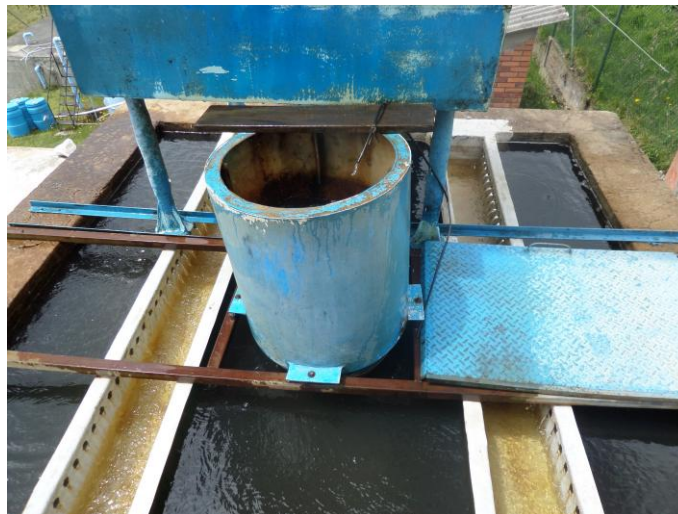
Imagen 5. Floculador de la PTAP de Guatavita
