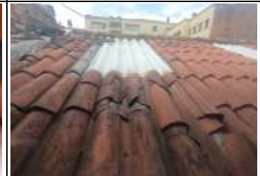
n FOTOGRAFIA No. 67 - rotura de tejas de barro e inapropiada intervención en cubierta con material incompatible
