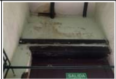
FOTOGRAFIA No. 69 - manchas de humedad en muros y cielo raso por filtración desde la cubierta
