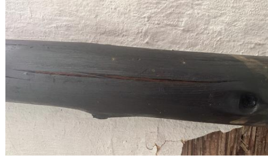
Grietas longitudinales y presencia de nudos en la madera rolliza
