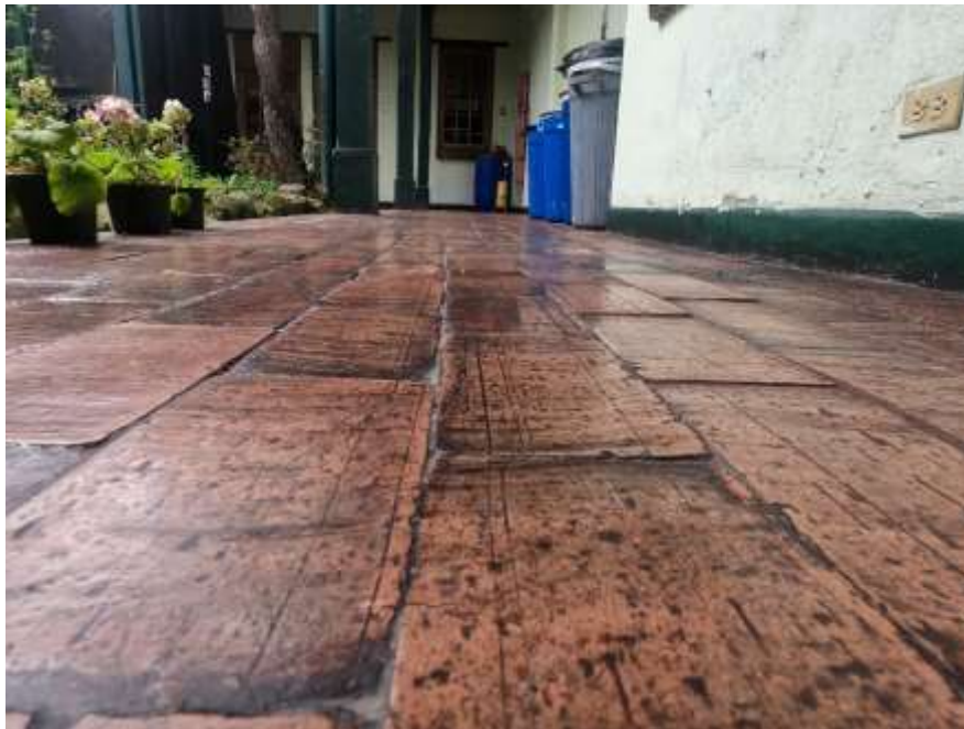
Imagen 6. Estado actual de la edificación. Fuente: Propia
