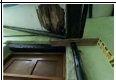
FOTOGRAFIA No. 79 - desprendimiento por pudricion total del cabezal de la viga en madera en el vano hacia la cocina
