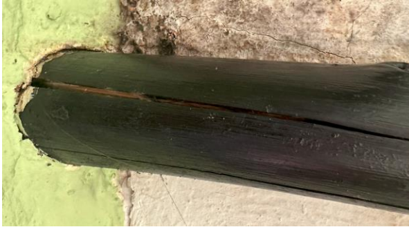
Grietas longitudinales y presencia de nudos en la madera rolliza
