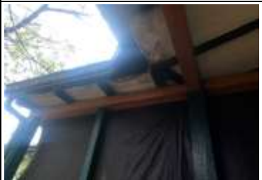
FOTOGRAFIA No. 70 - manchas de humedad en cielo raso por filtración desde la canal de aguas lluvias y bajantes
