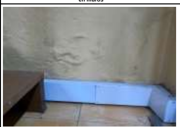
FOTOGRAFIA No. 80 - abombamiento de pintura sobre muro hacia lote baldío sobre carrera 3
