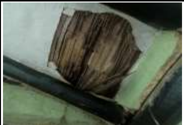
FOTOGRAFIA No. 65 - pudricion del chusque de la estructura de la cubierta
