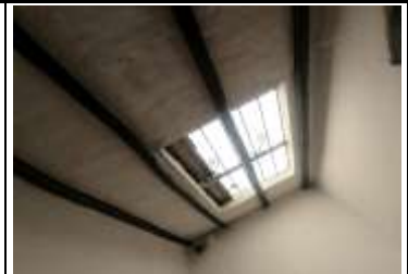
FOTOGRAFIA No. 64 - mala intervención en cubierta (lucarna) con material incompatible
