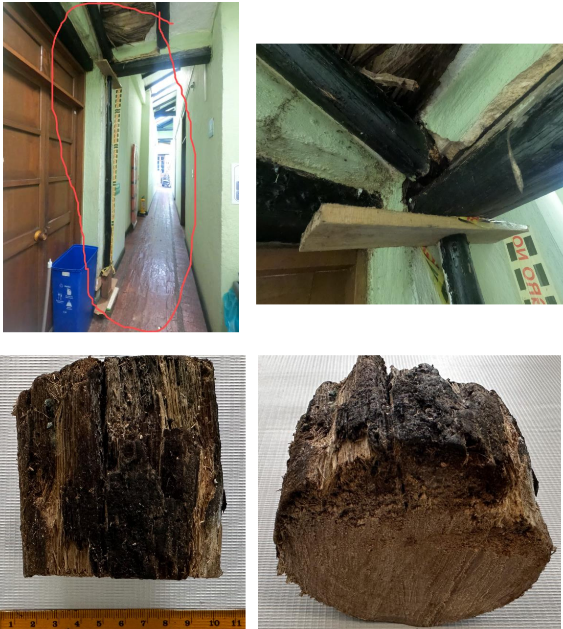
Imagen 5. Muestra de madera tomada de un poste utilizado como columna en el área de la cocina para realizar proceso de identificación
