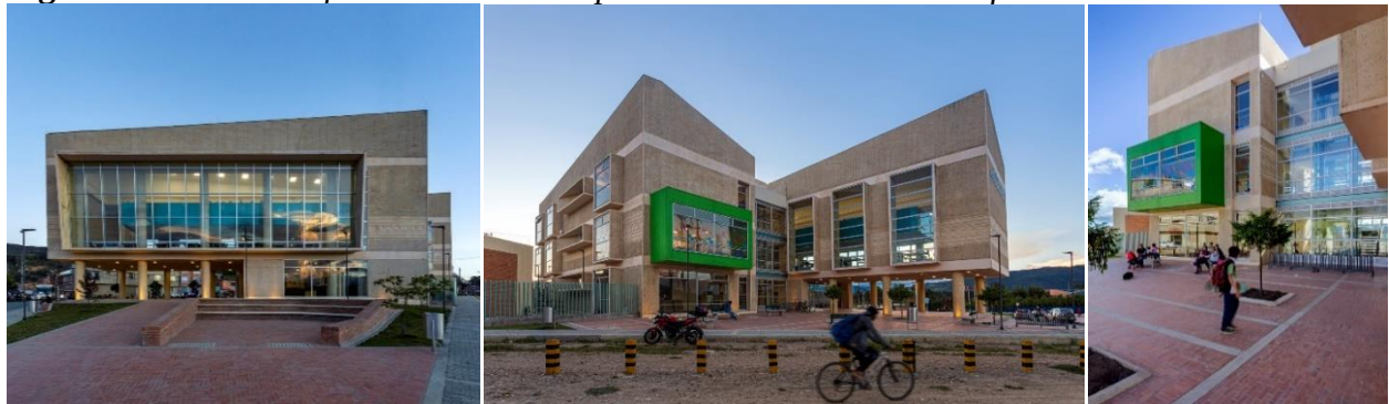
Figura 38. Biblioteca pública de Tocancipá. Vistas exteriores del edificio
