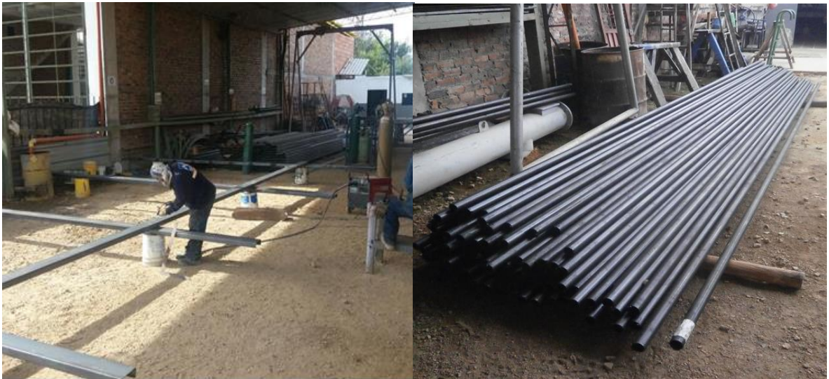
Ilustración 42. Fabricación de estructura en taller.
