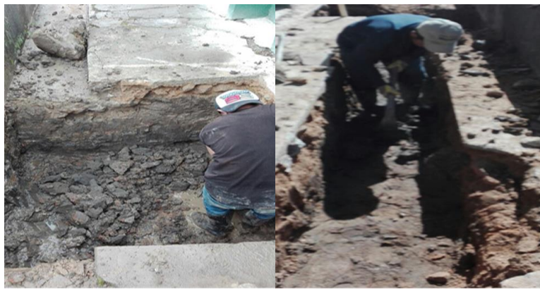
Ilustración 33. Excavación manual en material común.
