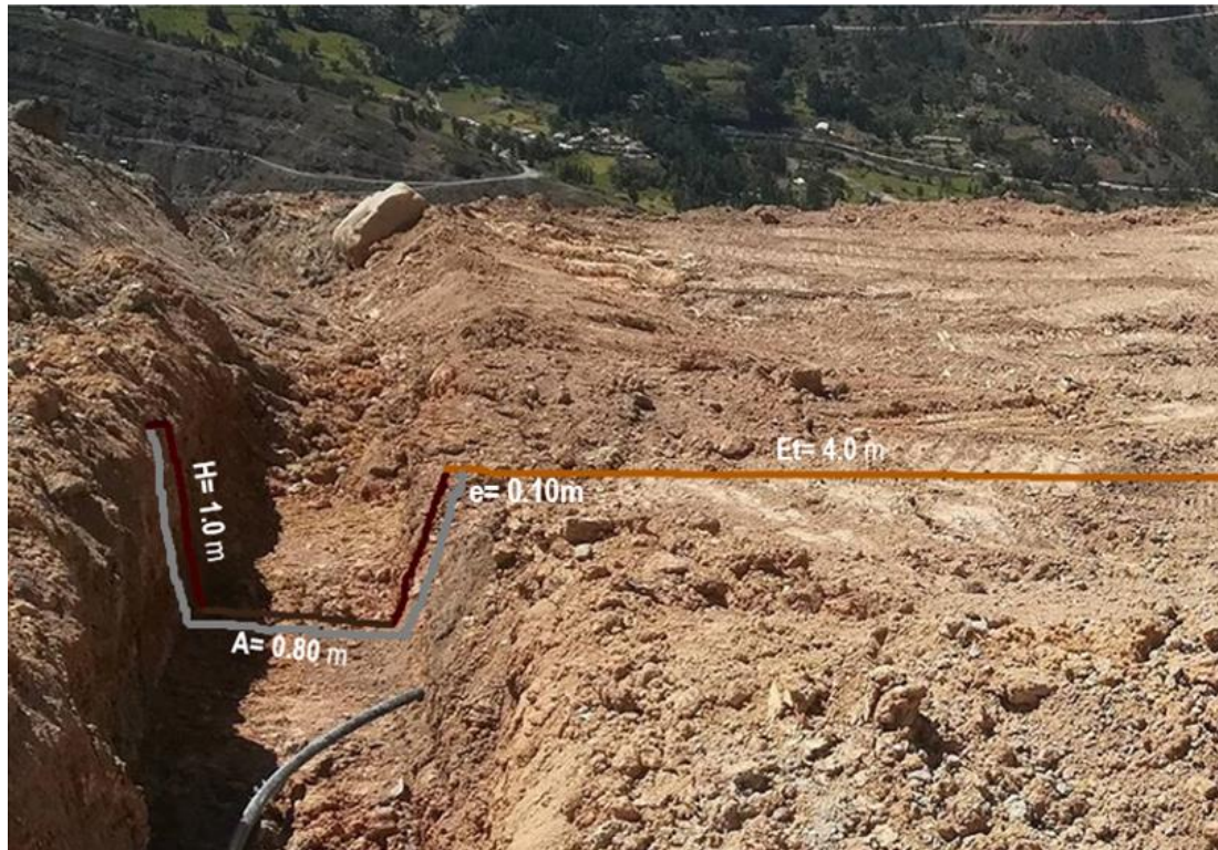
Ilustración 15. Sección transversal de zanja de coronación perimetral.
