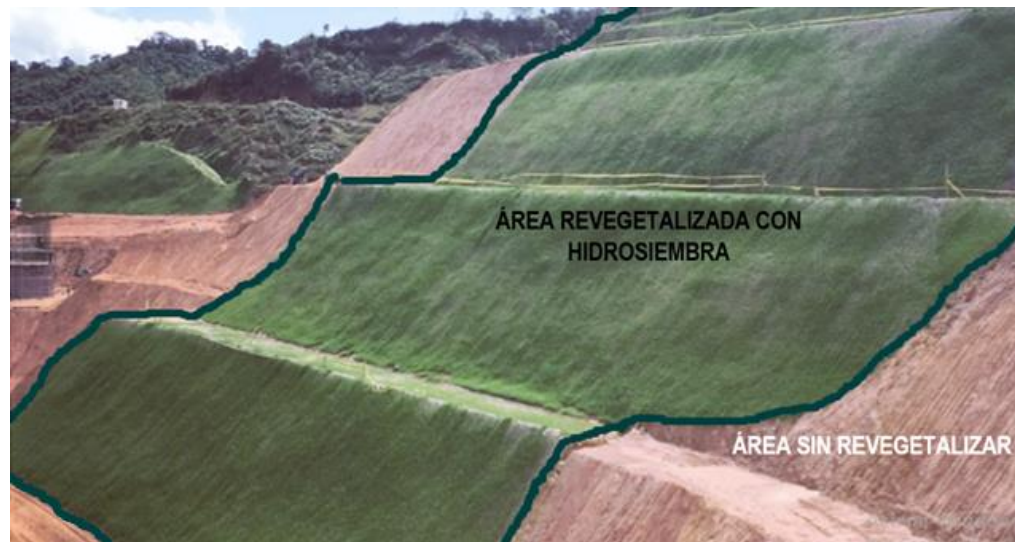
Ilustración 10. Conformación básica de revegetalización con hidrosiembra.
