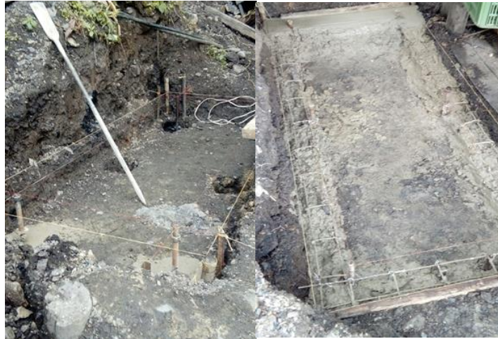
Ilustración 53. Construcción de placa de soporte y sistema de drenaje del malacate.
