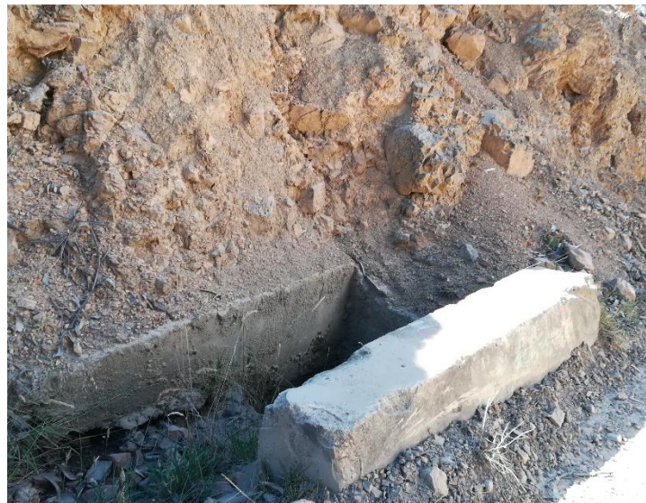
Ilustración 14. Alcantarilla para la disposición final del agua superficial.
