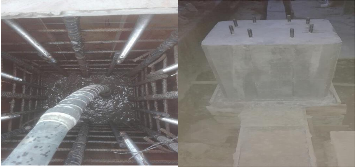
Ilustración 38. Columnas en concreto.
