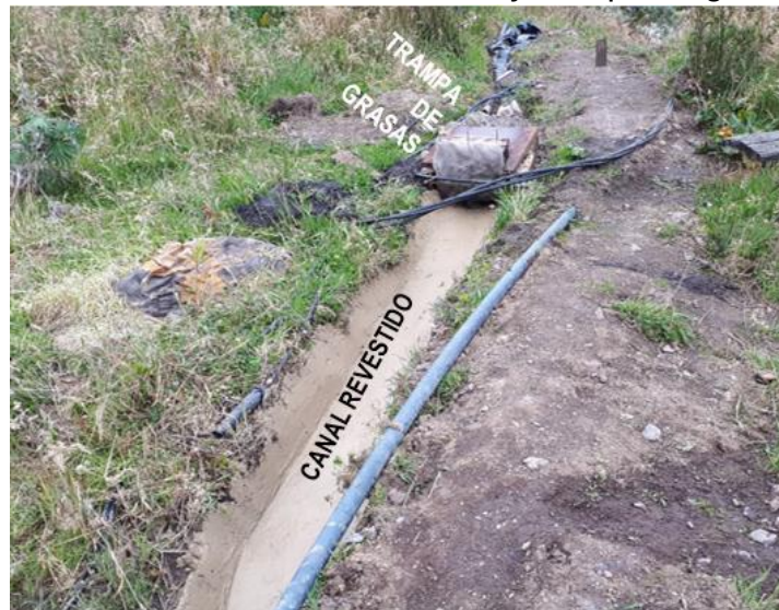
Ilustración 54. Construcción de canal revestido y trampa de grasas.
