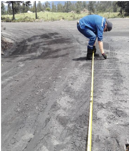
Ilustración 31. Caracterización geométrica de la vía.
