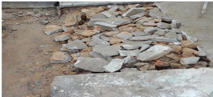
Ilustración 34. Excavación manual en material común.
