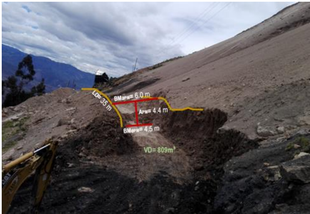
Ilustración 7. Propiedades geométricas de trincho colmatador de roca.
