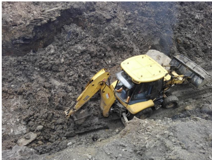
Ilustración 24. Verificación de labores de excavación y retiro.
