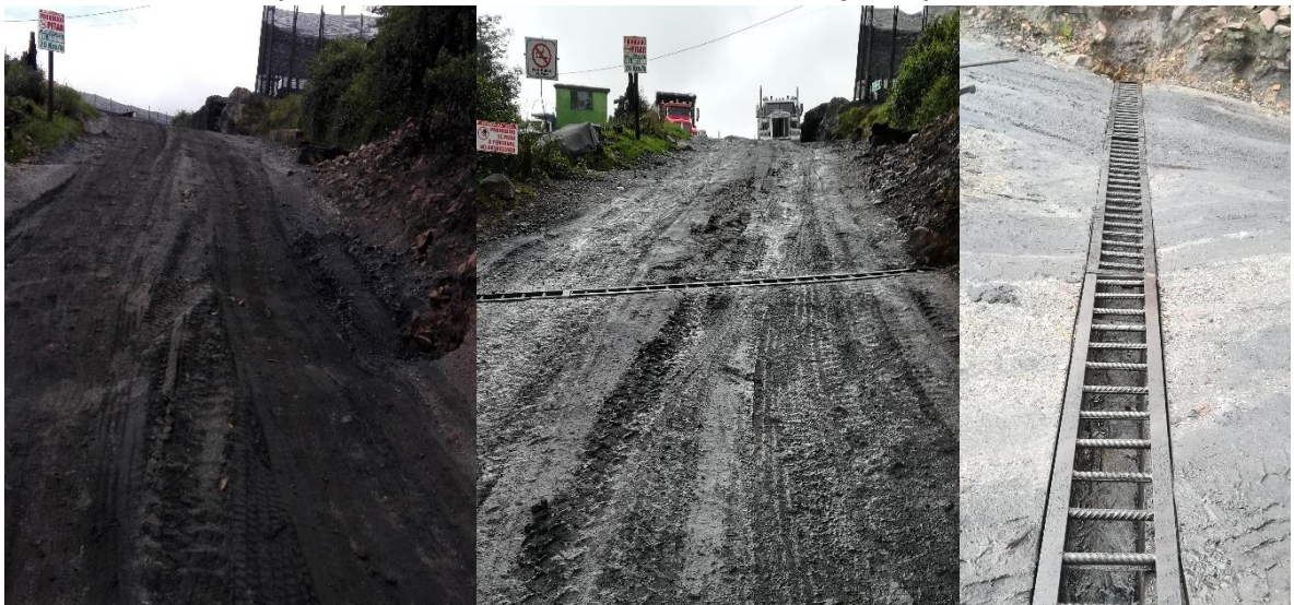
Ilustración 29. Optimización de condiciones de drenaje requeridas.
