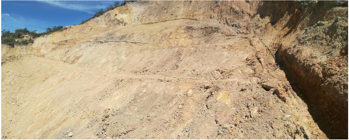
Ilustración 16. Verificación de avance final de las obras de drenaje.
