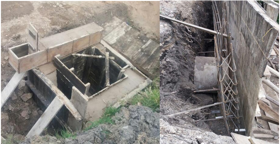
Ilustración 51. Supervisión técnica de labores de construcción.
