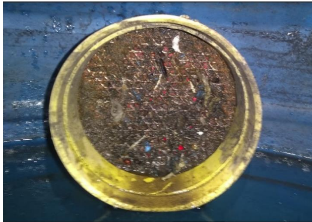
Fig 15. Filtro tanque primeras aguas lluvias
