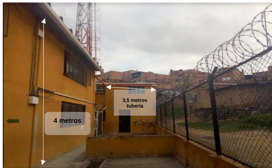
Fig 18. Instalación canaletas y bajantes
