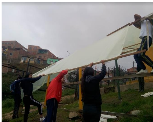
Fig 6. Instalación plástico para invernaderos
