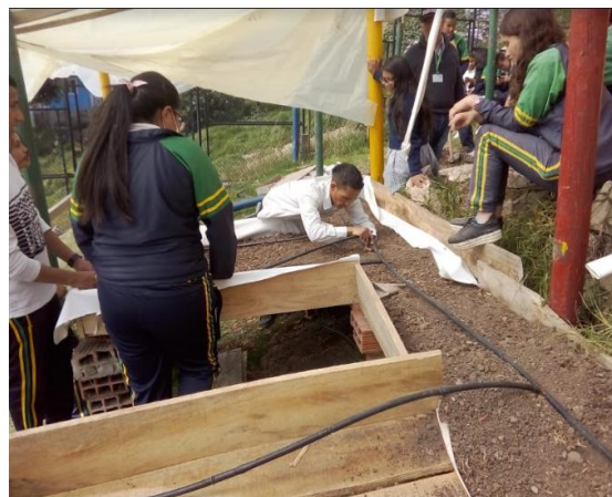
Fig 8.Instalación de laterales y sub-laterales
