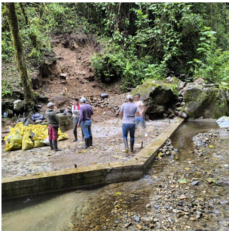
Fotografía 2. Bocatoma de fondo del Distrito de Riego San José (registro de campo).
