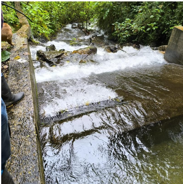
Fotografía 1. Cauce de la Quebrada San Antonio en la captación.
