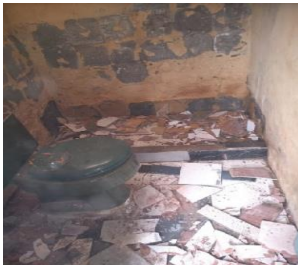
Figura 4. DEMOLICIÓN PAÑETE MURO 0,15 M
