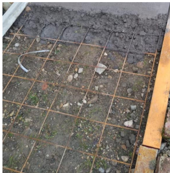
Figura 7. REFUERZO MALLA ELECTROSOLDADA
