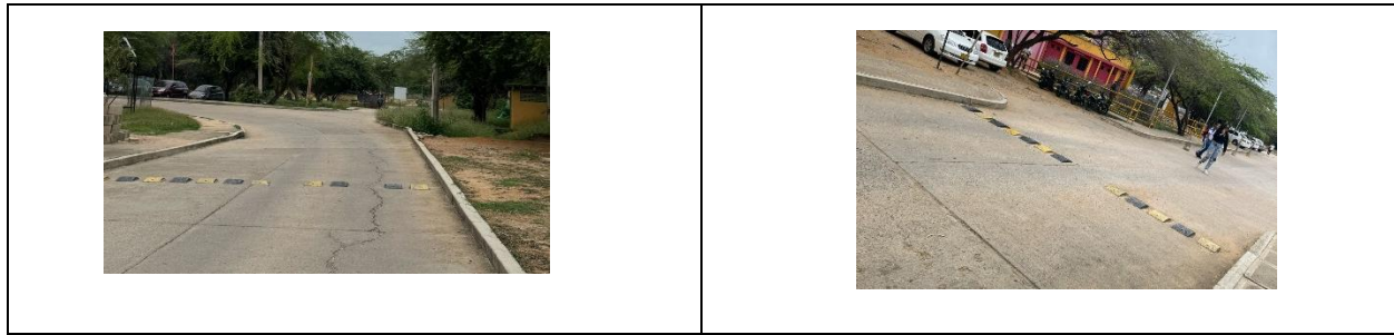
Figura 18. Reductor de velocidad
