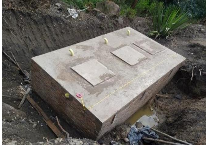
Figura 30. Resultado final 2do pozo.
