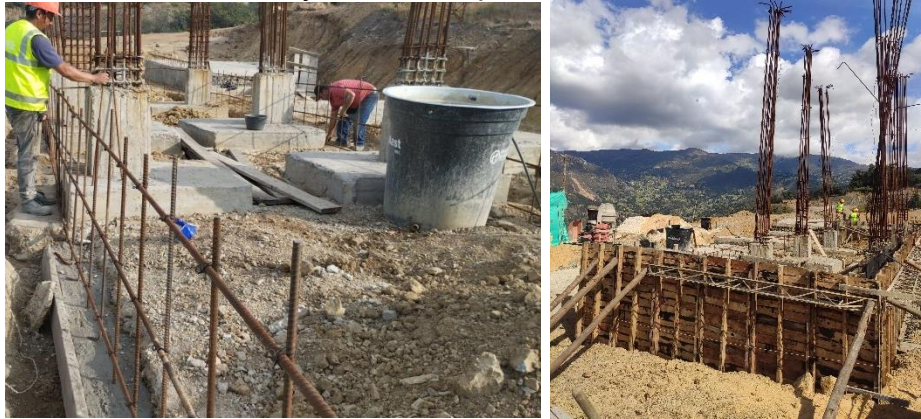
Figura 32. Armado de acero y encofrado para estructura del muro de contención.
