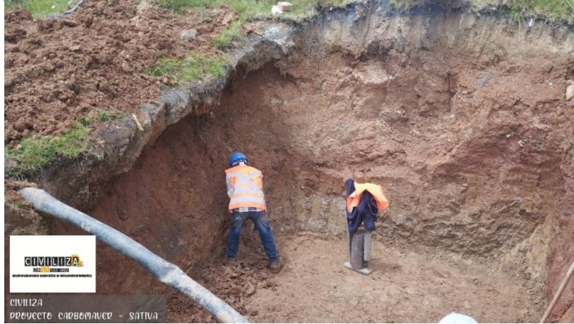
Figura 21. Excavación de la zona destinada para el 1er pozo.
