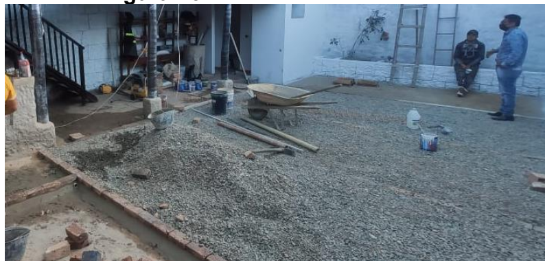
Figura 16. Relleno de zona abierta.
