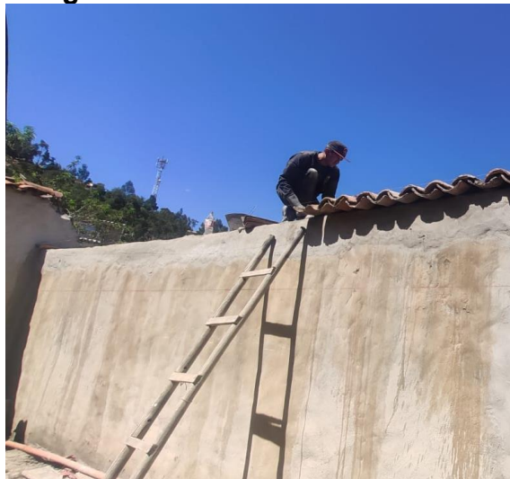
Figura 6. Reforma muros externos.
