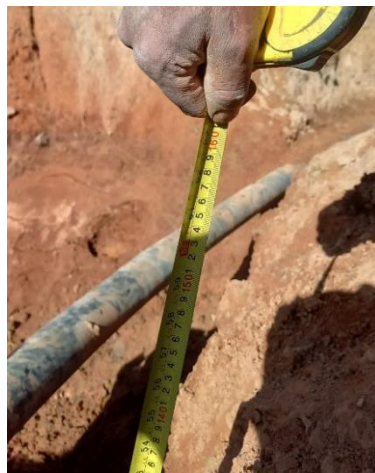
Figura 23. Verificación del nivel de excavación.
