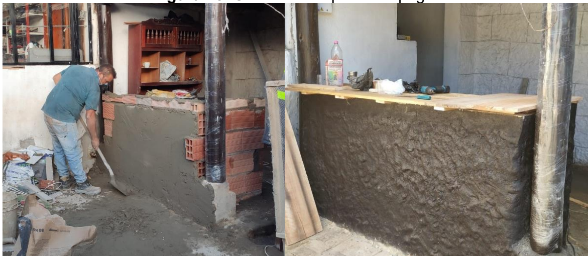
Figura 13. Construcción punto de pago.
