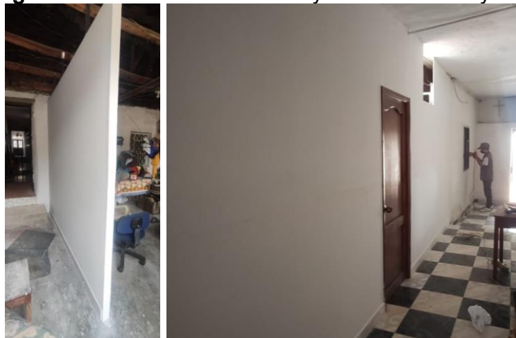
Figura 12. Acabado final de 1er y 2do muro de drywall.
