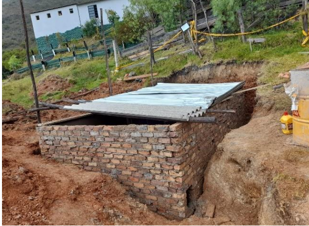
Figura 26. Muro en mampostería 1er pozo.
