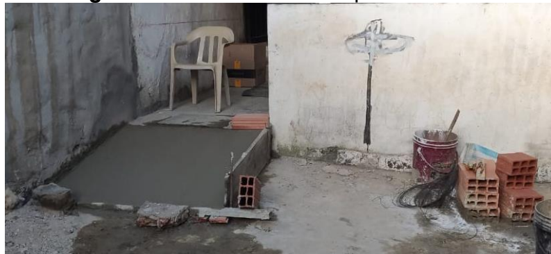
Figura 15. Construcción rampa de acceso.
