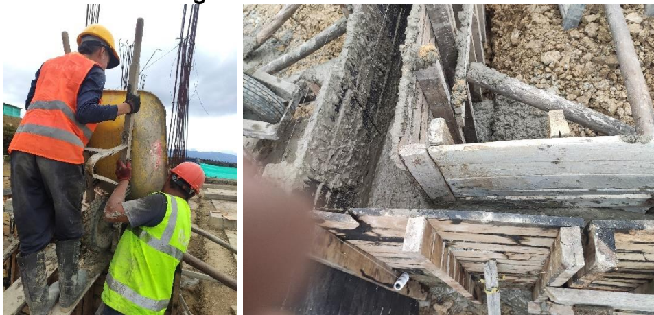
Figura 33. Vaciado de concreto
