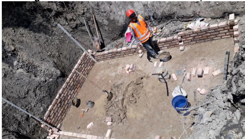
Figura 25. Construcción de losa en 2do pozo.
