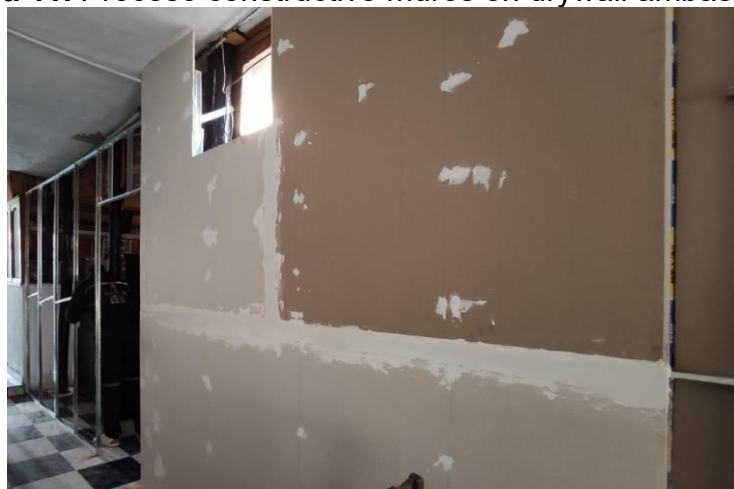
Figura 11. Proceso constructivo muros en drywall ambas caras.
