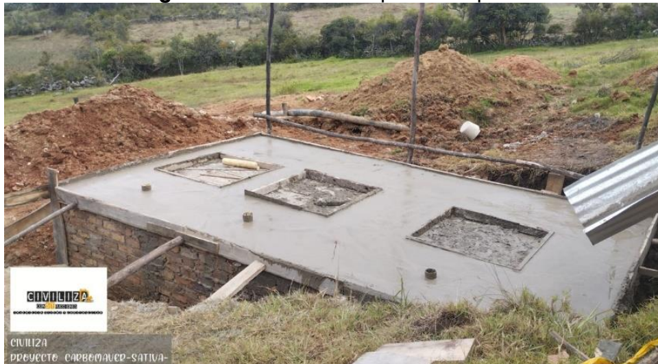
Figura 29. Fundición de placa 1er pozo.
