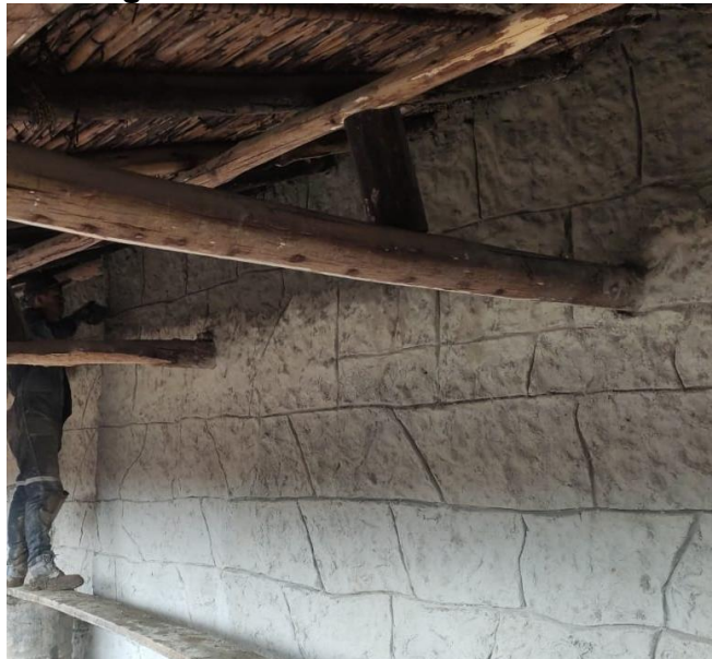
Figura 5. Reforma muros externos.
