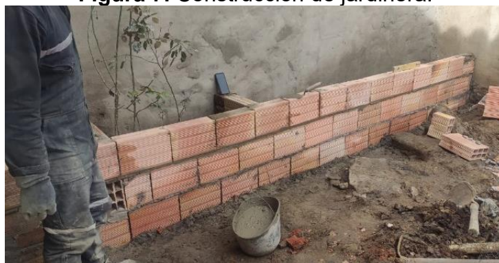
Figura 7. Construcción de jardinera.
