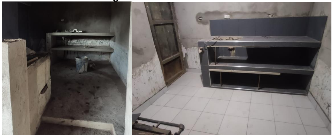
Figura 8. Reforma de cocina.
