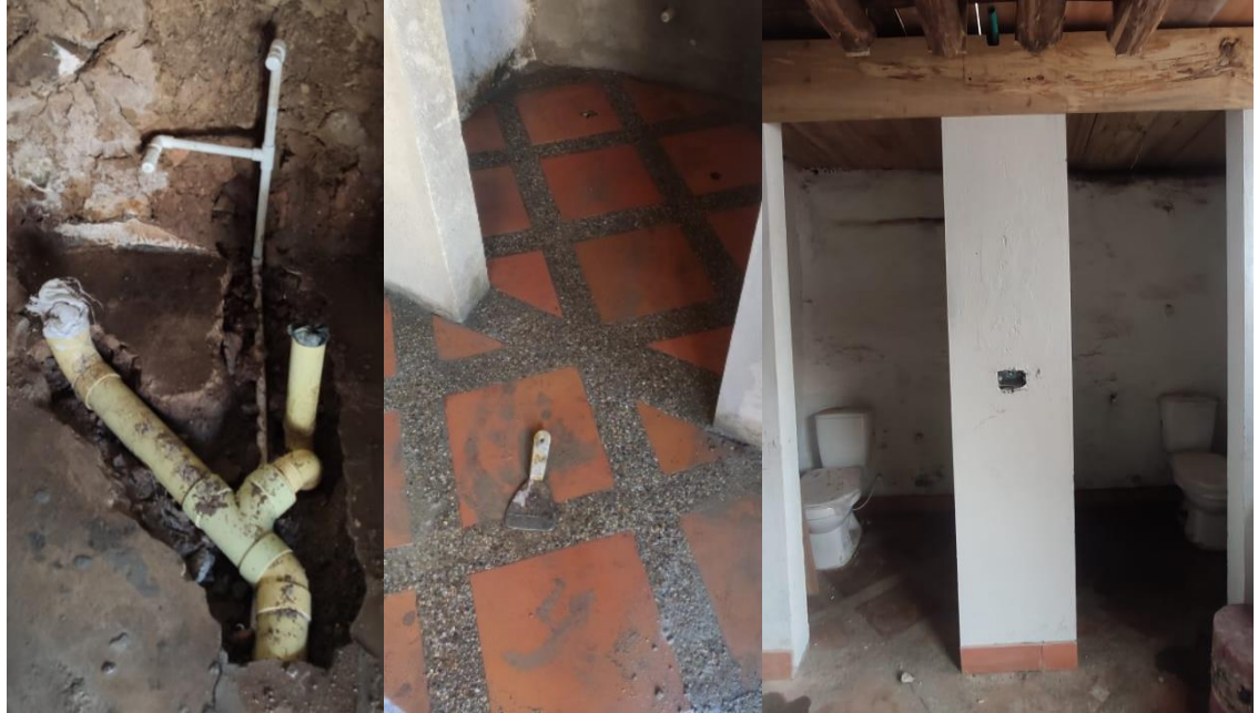
Figura 9. Proceso constructivo de baños.
