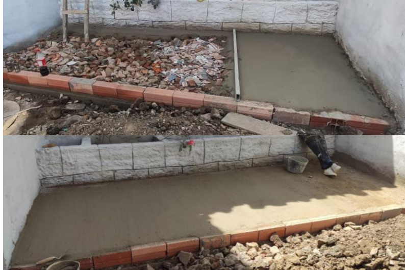
Figura 14. Construcción de tarima.
