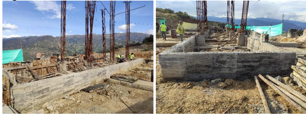
Figura 34. Resultado construcción de muros de contención perimetral.
