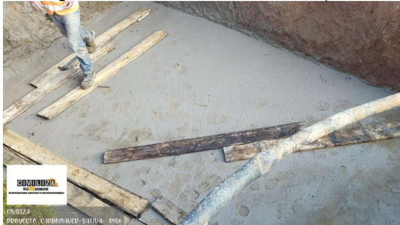
Figura 24. Construcción de losa en 1er pozo.
