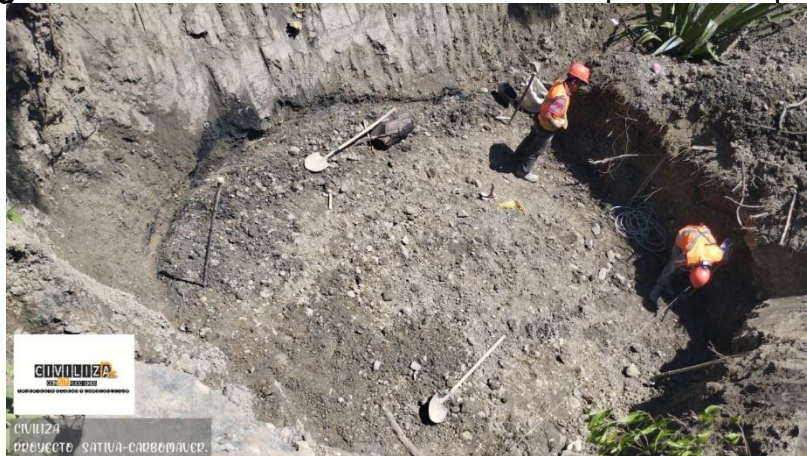
Figura 22. Excavación de la zona destinada para el 2do pozo.
