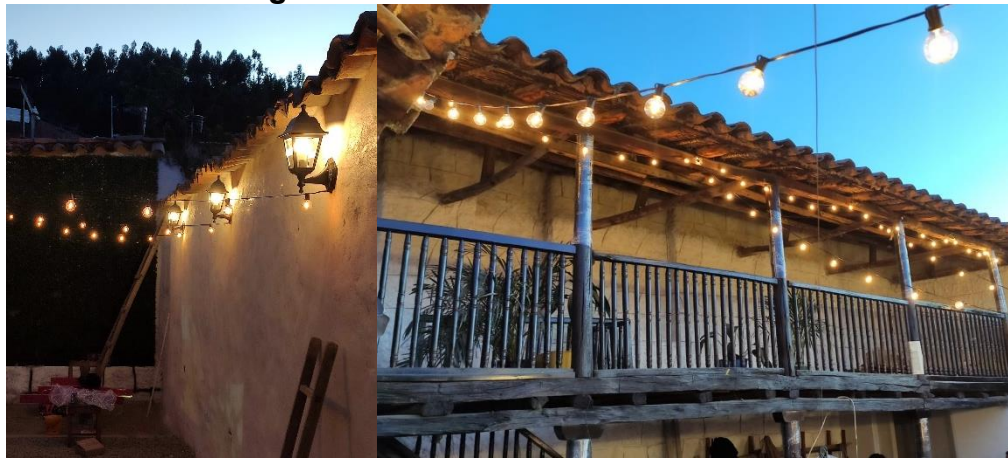
Figura 17. Instalación de iluminación.
