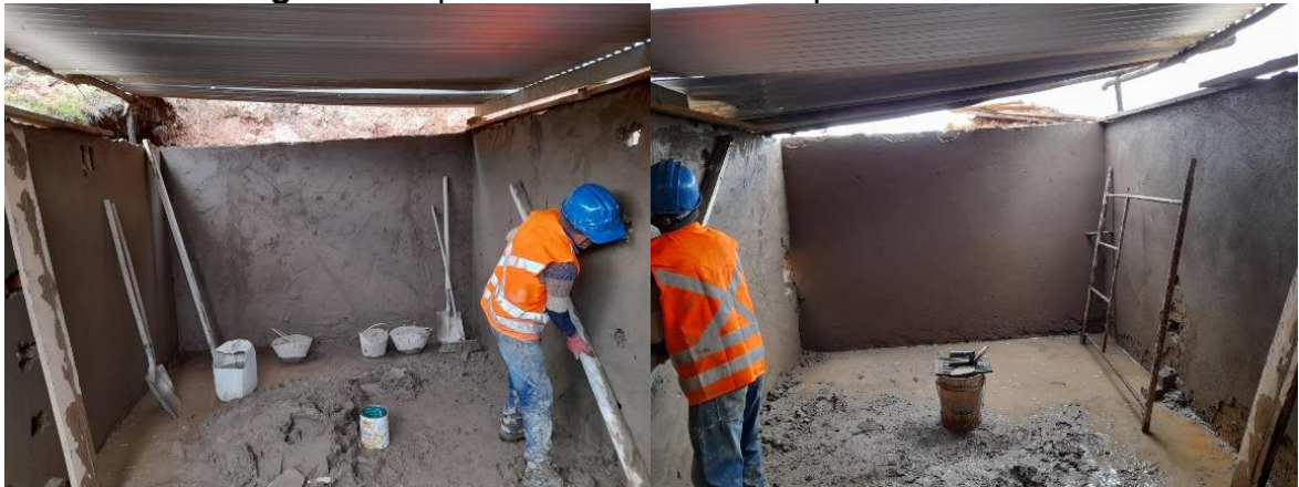
Figura 27. Aplicación mortero 1:3 impermeabilizado.
