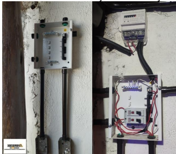
Figura 18. Instalación de caja de control y contador.
