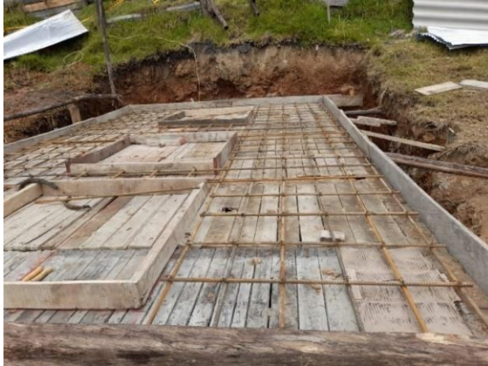
Figura 28. Encofrado y armado refuerzo de placa.
