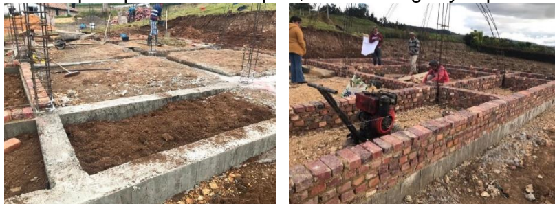
Figura 27. Nivelación para placa de contrapiso, fundición vigas y zapatas
