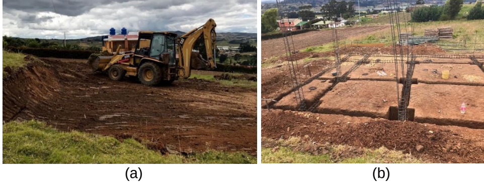
Figura 25. Descapote y limpieza terreno Jenesano
