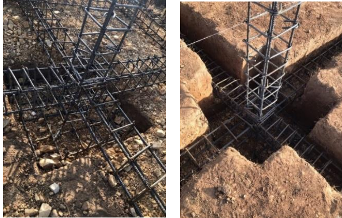
Figura 26. Armadura de vigas, zapatas y columnas.
