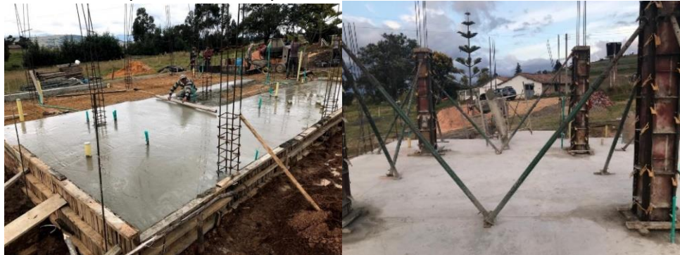
Figura 28. Fundición placa de contrapiso.
