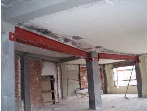
Figura 64. Ejemplo de refuerzo con vigas metálicas
