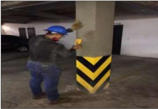
Figura 14. Detección acero de refuerzo
