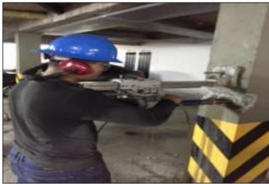
Figura 24. Extracción de núcleo
