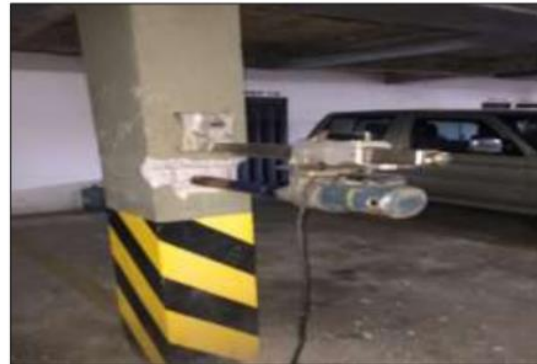
Figura 26. Extracción de núcleo
