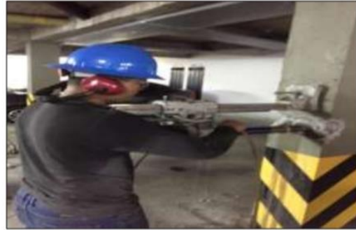
Figura 25. Extracción de núcleo
