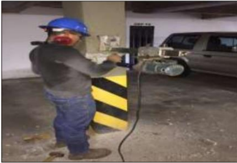
Figura 23. Extracción de núcleo
