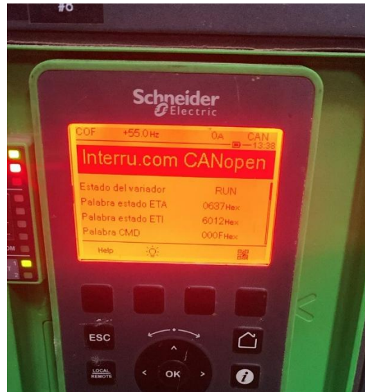
Figura 26. Variador ATV 930 con error de comunicación
