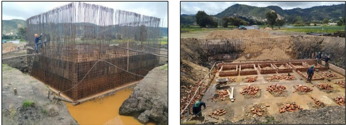
Ilustración 4: Visita de Obra PTAR- Samacá
