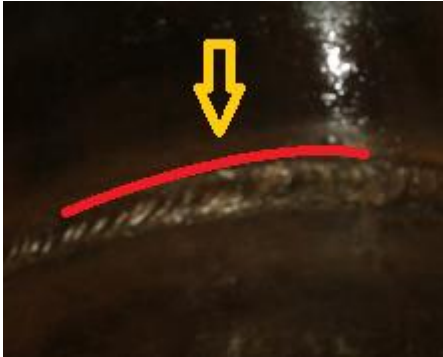
Figura 52 Vista de trabajo para el scan C
