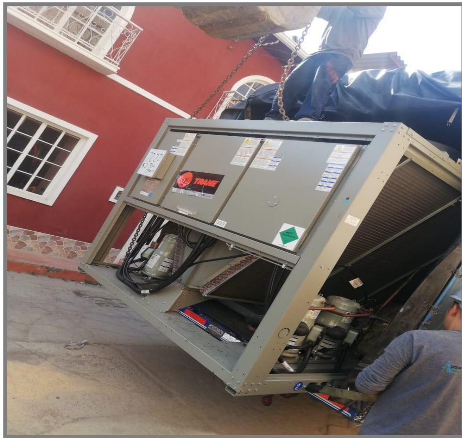
Figura 16. Descargue de equipo de aire acondicionado.
