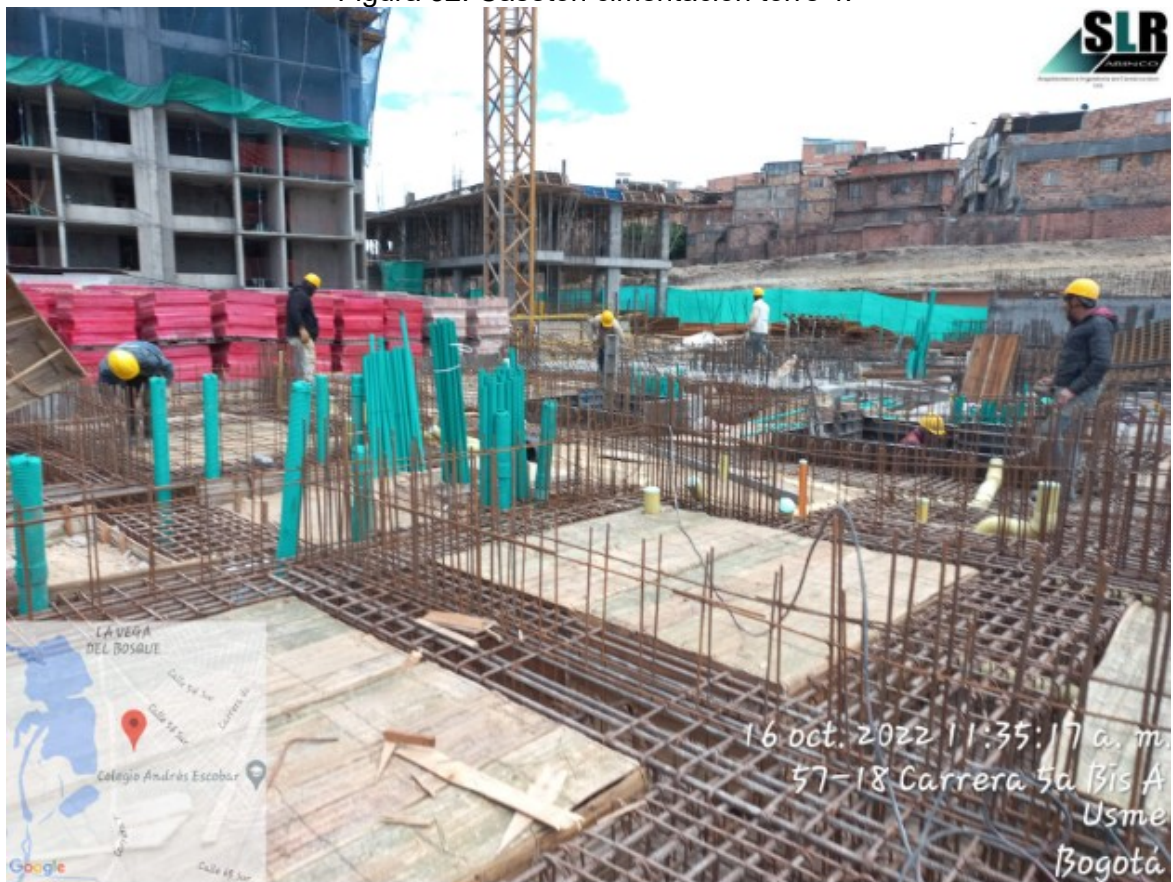
Figura 32. Casetón cimentación torre 4.
