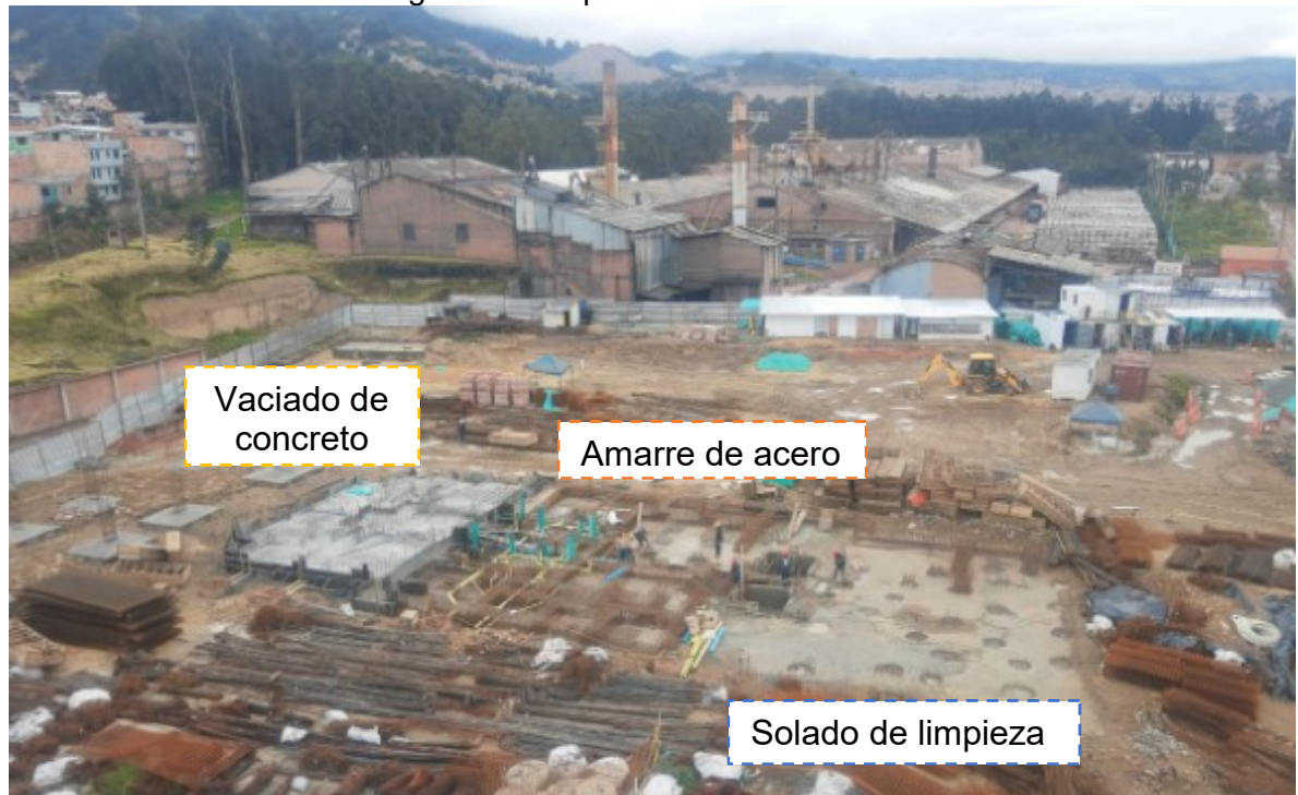
Figura 19. Etapas de una cimentación
