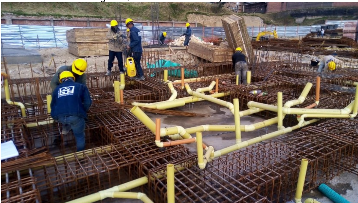
Figura 18. Instalación de redes y de casetón
