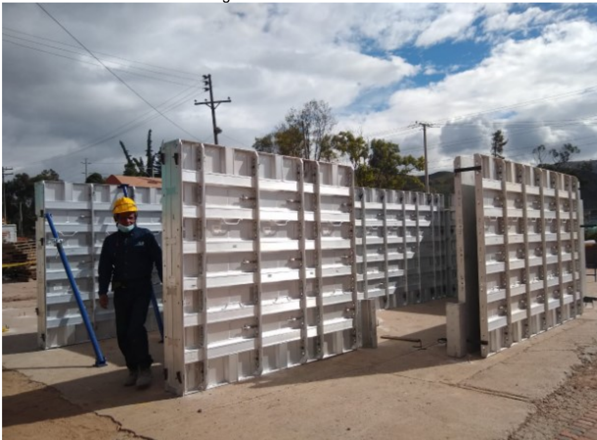
Figura 21. Armado en seco.
