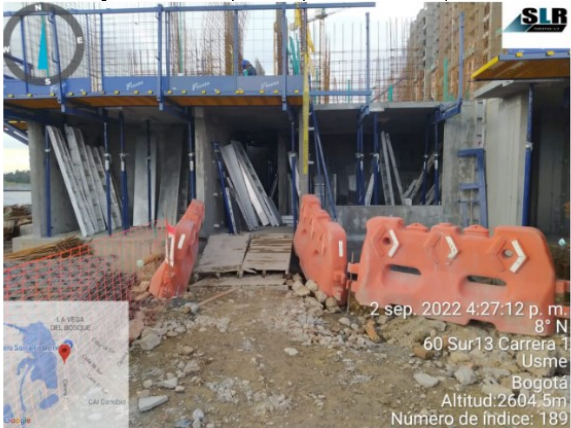
Figura 24. Armado de palomeras para amarre de acero piso 2.
