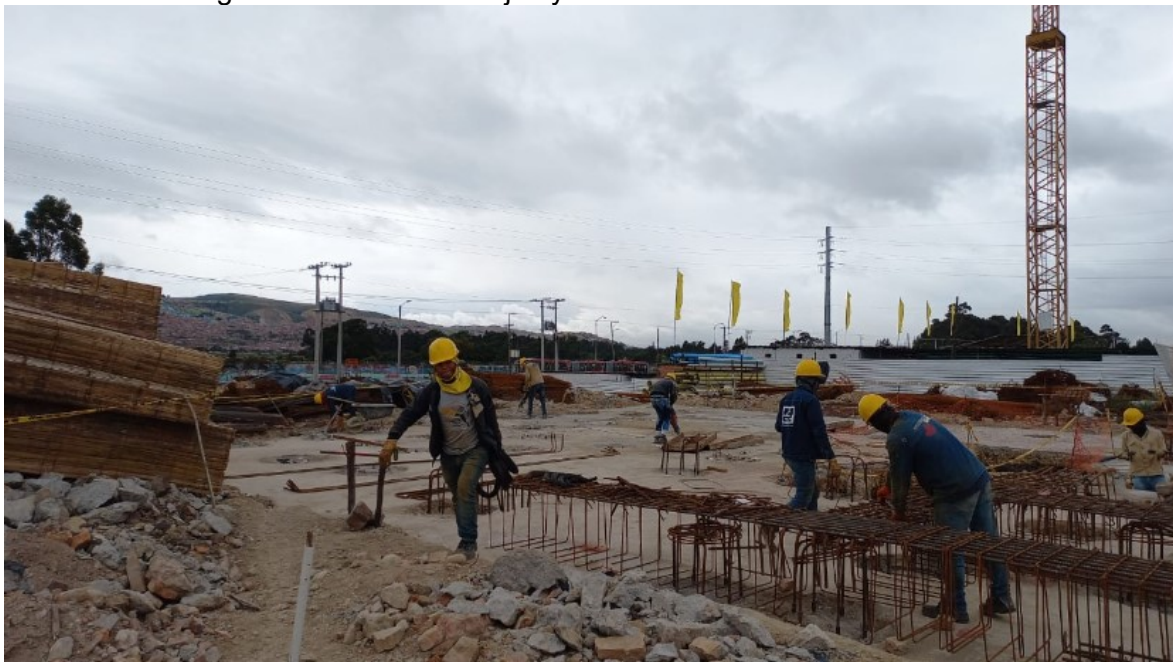
Figura 17. Trazado de ejes y amarre de acero de cimentación
