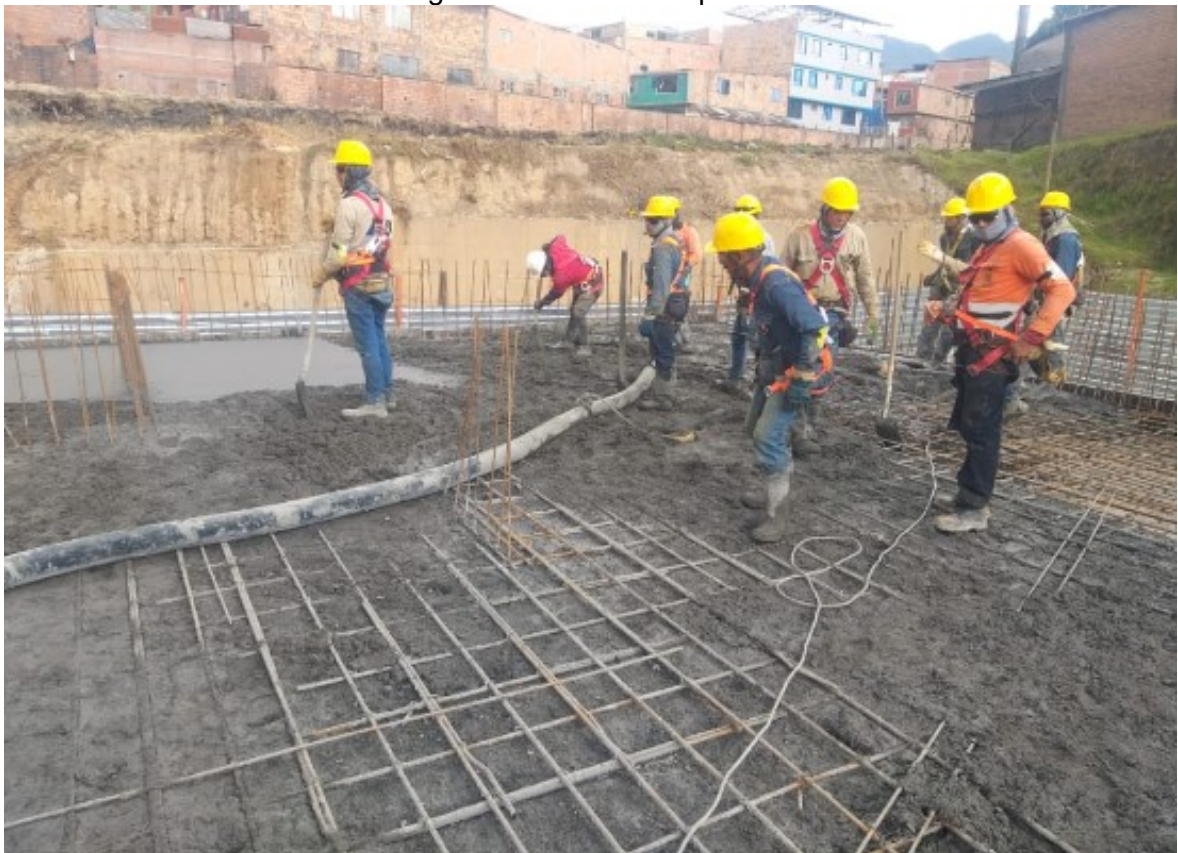
Figura 29. Vaciado de placa.
