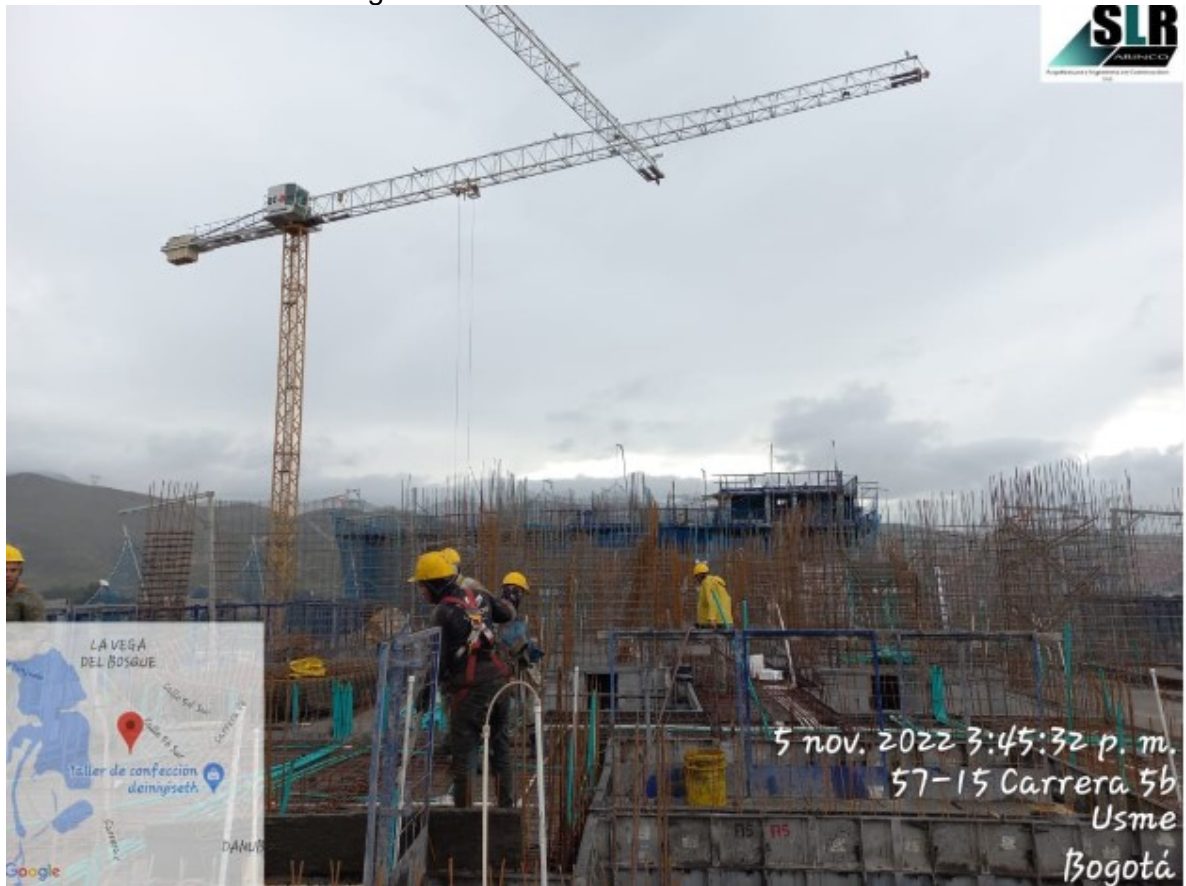
Figura 20. Armado de muros en acero.
