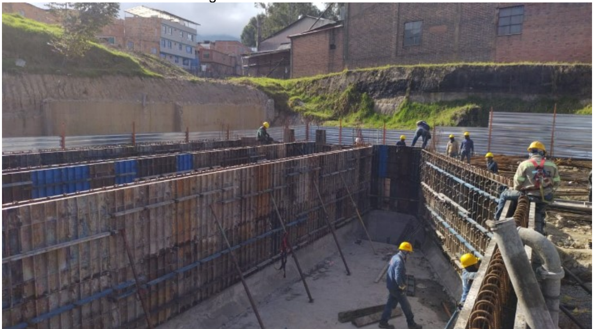
Figura 28. Vaciado de muros.
