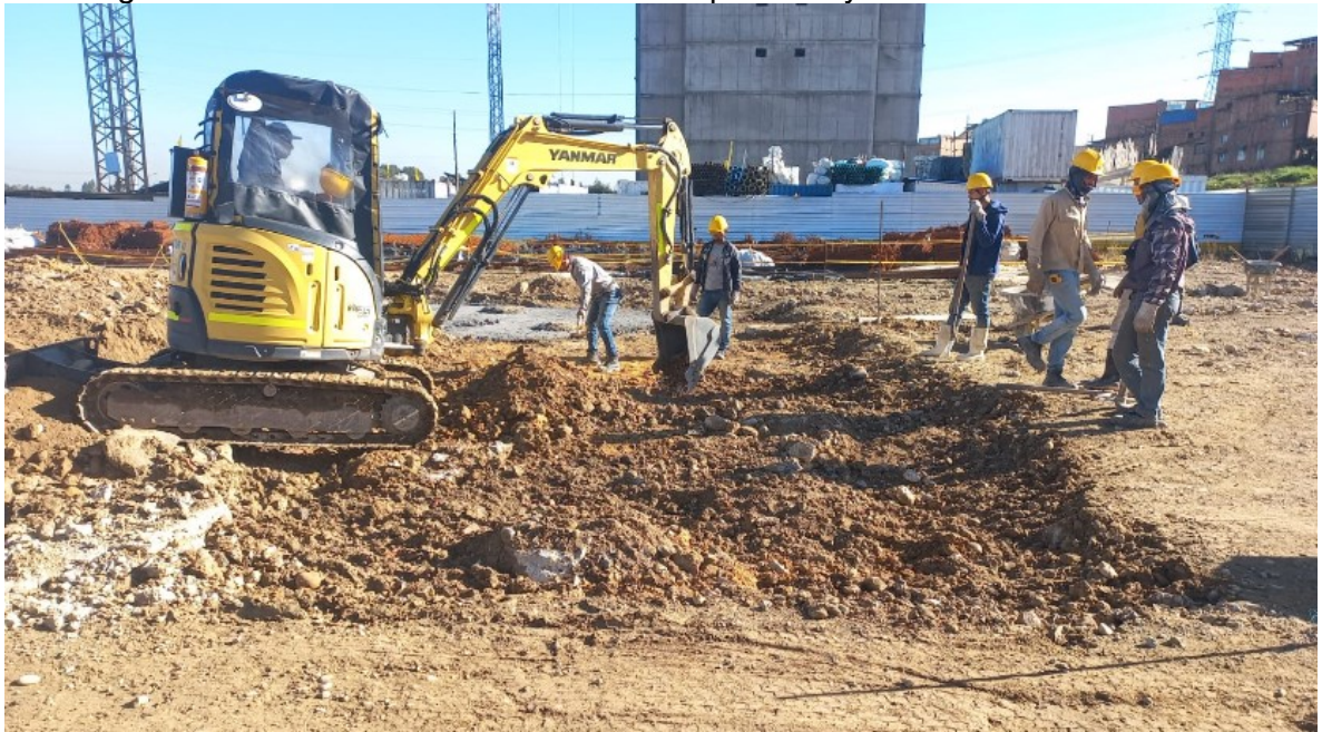
Figura 16. Definición suelo de fundación – perfilado y conformación del terreno
