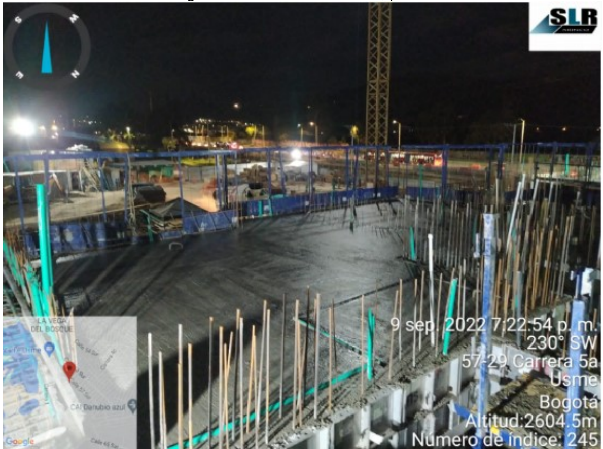
Figura 23. Vaciado de concreto, placa.
