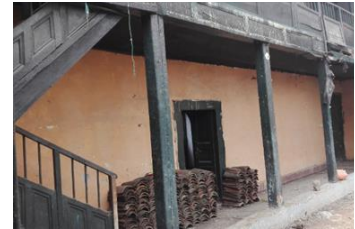
Figura 21 Vista columnetas en madera 15x15 primer piso
