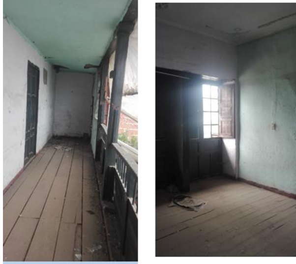
Figura 11 Tablado Original sector segundo piso
