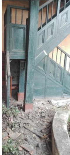
Figura 13 Vista general escalera en adera
