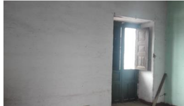
Figura 17 Vista alcoba 3- segundo piso
