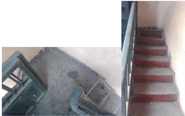
Figura 12 Primer tramo escalera en madera que termina
