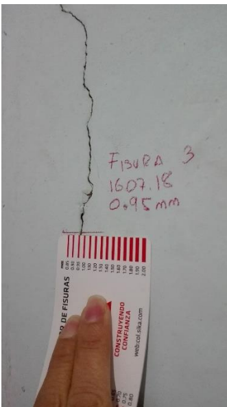
Figura 40 Seguimiento a Fisura 3
