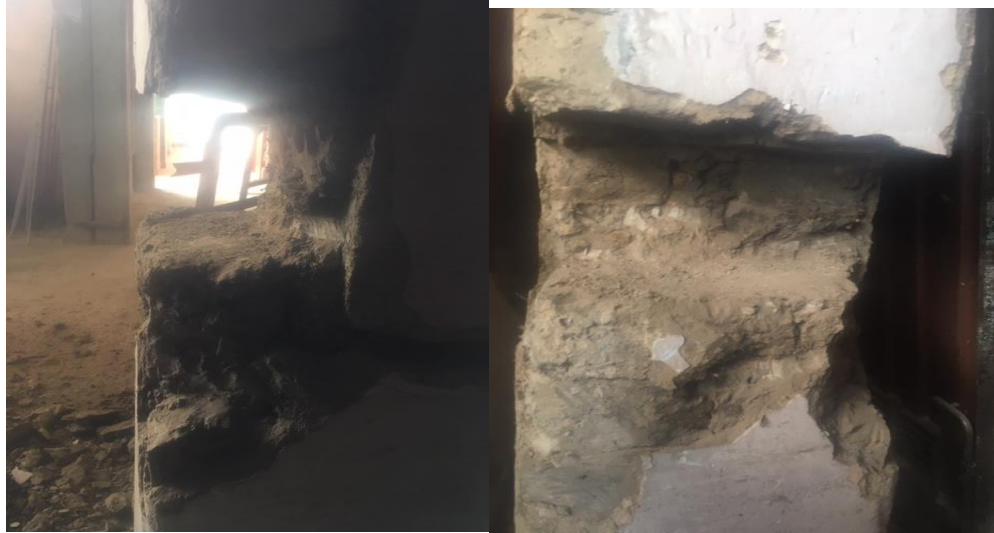
Figura 41 Extracción de los adobes en muro divisorio de cocina y patio
