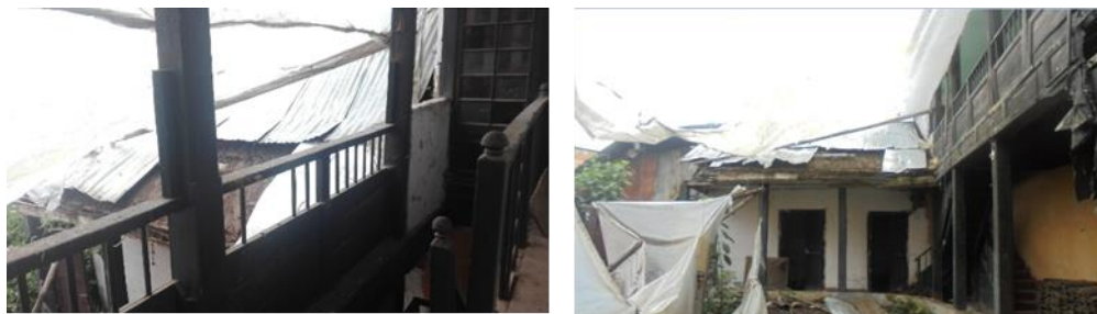
Figura 8 Aspectos Estructurales de la Cubierta sector posterior de la casa (patio)
