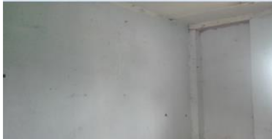
Figura 26 Pañetes de cal y cemento
