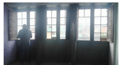
Figura 18 Vista alcoba 2- segundo piso
