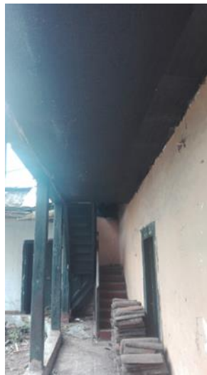
Figura 22 Vista hall primer piso
