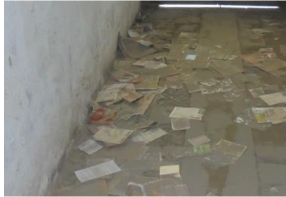
Figura 25 En zona del vestíbulo el piso es en piedra y cintas de concreto.
