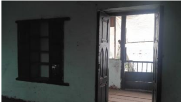
Figura 16 Vista alcoba 1- segundo piso
