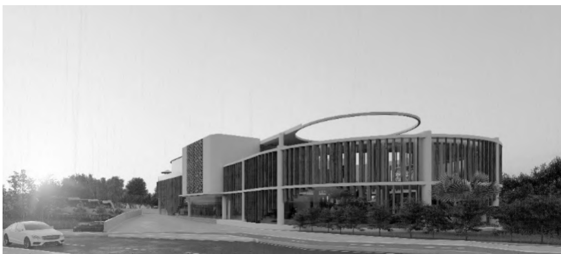
Ilustración 14. Fachada con pérgolas verticales para controlar el paso de luz solar. Elaboración propia
