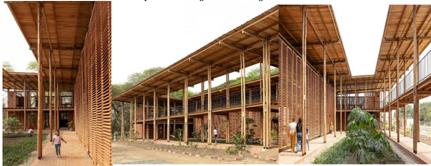
Figura 20. Foto del sistema estructural que maneja Las Tejedoras
