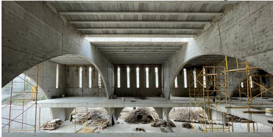
Figura 11. Foto del sistema estructural del centro comunitario La Pulga
