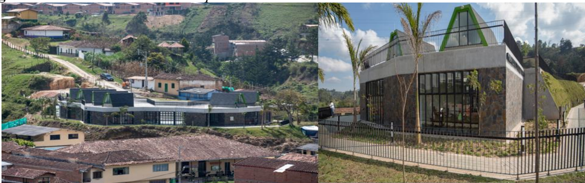
Figura 14. Vistas externas de Parque San Vicente Ferrer
