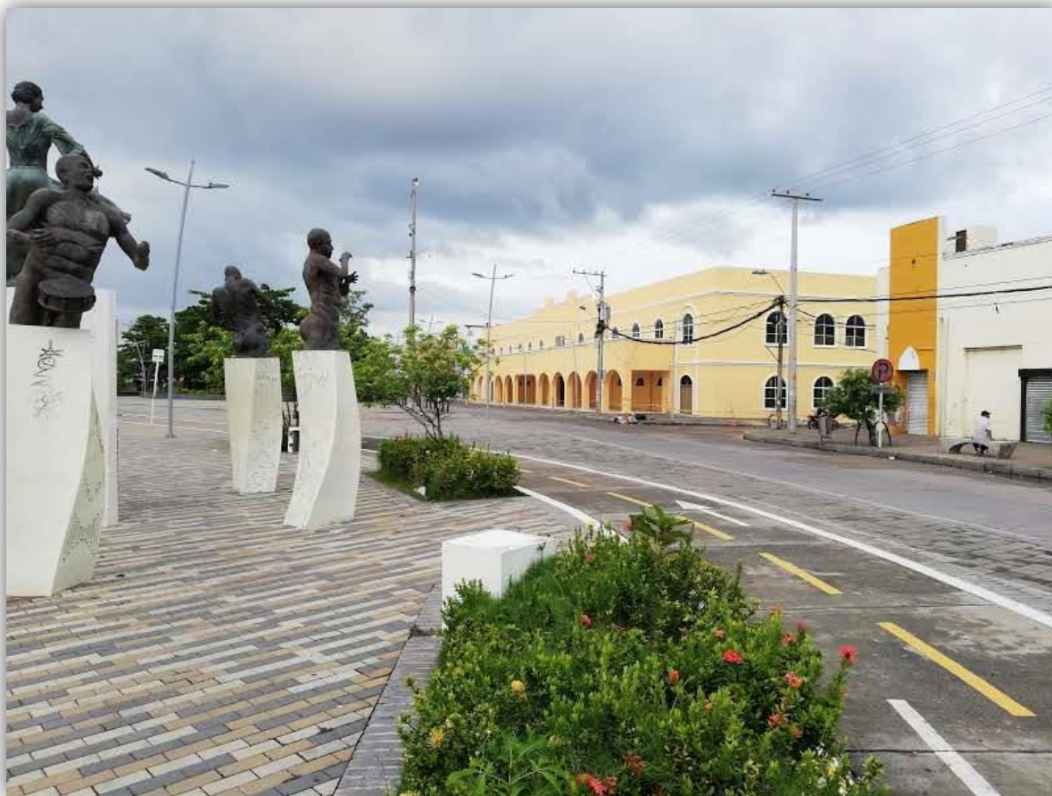
Imagen 9: Fuente propia, foto tomada en el Centro cultural y artesanal Av Primera, Montería. Restauración de patrimonio arquitectónico.
