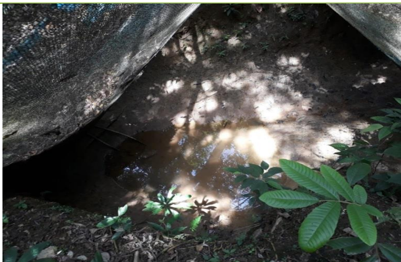
Fotografía 11 Aljibe (finca privada).
